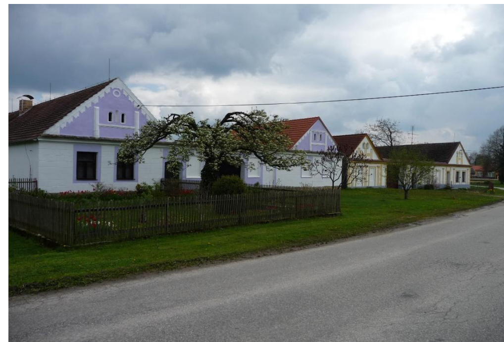
Pohled na typická venkovská stavení blatského typu
