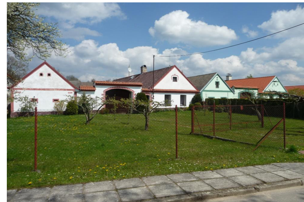
Dochovaná původní stavení
