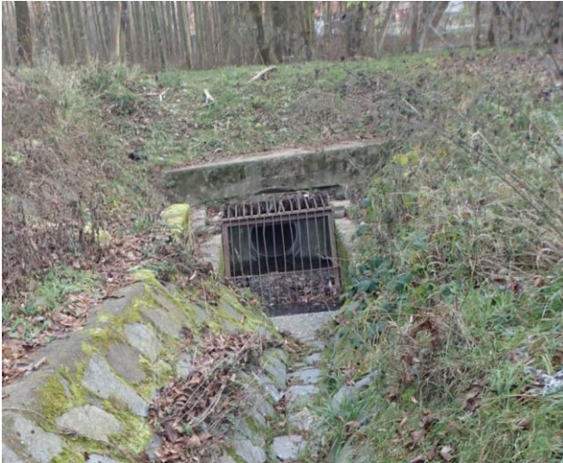
Obrázek 13 Přechod otevřeného koryta do trubního systému – Sedlecký potok, Praha Suchdol (MUID objektu v modelu 572825)
