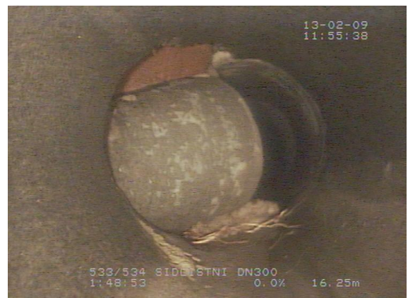
Obrázek 19 BAG – poloha 9, vyčnívající přípojka
