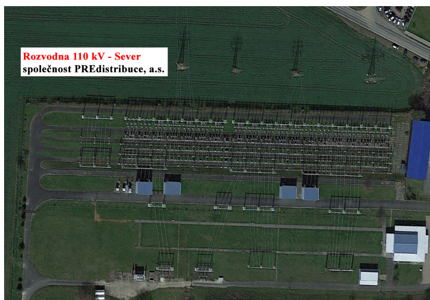
Obr. 20 – Pohled na stávající rozvodnu Tr 110/22 kV Sever – 4. 2. 2016. 30
