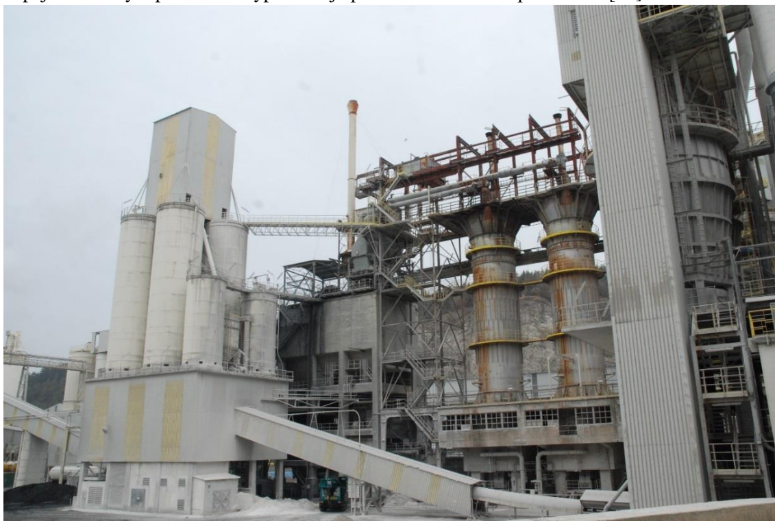
Obrázek 45 Pece ve vápence Čertovy schody
