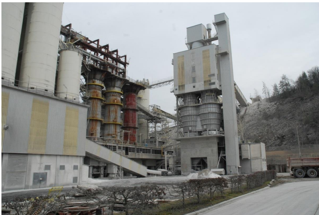
Obrázek 46 Vstup materiálu do vápenky Čertovy schody
