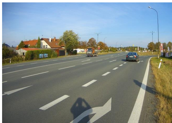
Obr. 13 - Místo zrušeného přechodu pro chodce
