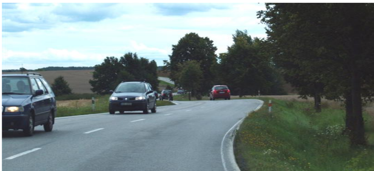
Obrázek č. 103. Úsek Lišov – Štěpánovice nevhodné směrové a výškové vedení.[autor]
