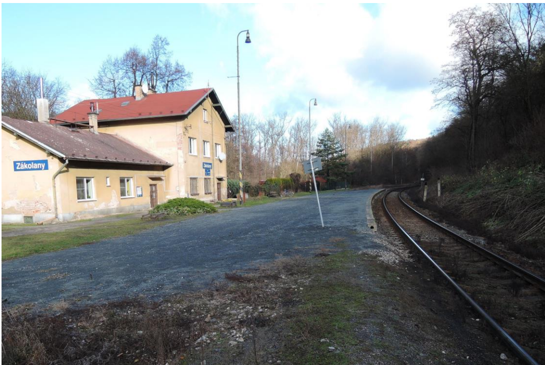
zastávka Zákolany s bývalou výpravní budovou
