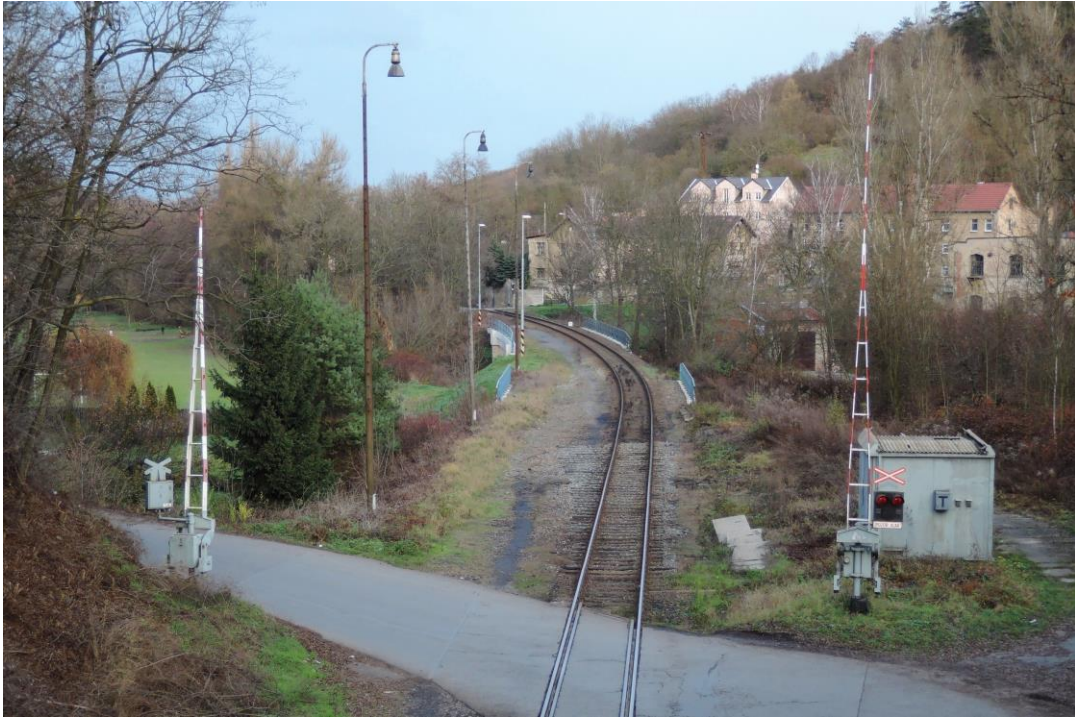
přejezd P2451 v ev. km 17,570, za přejezdem jsou dobře patrné pozůstatky po nedávno odstraněné výhybce
