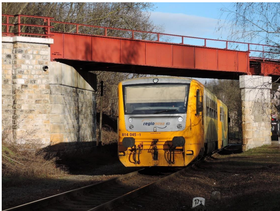
Obrázek 4.9 – Osobní vlak Kralupy n. Vlt. – Kladno vedený motorovou jednotkou řady 814 v místě křížení tratí 093 a 121 v Zákolanech (28. 11. 2016; foto: autor)
