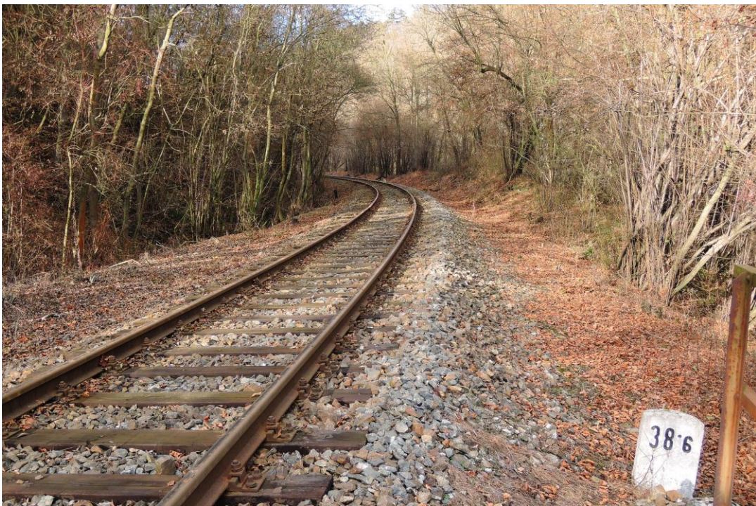
oblouk R = 293 m, ze kterého v těchto místech odbočuje spojka ve variantě Zákolany (pohled proti hrotu výhybky, směr odbočení doprava)
