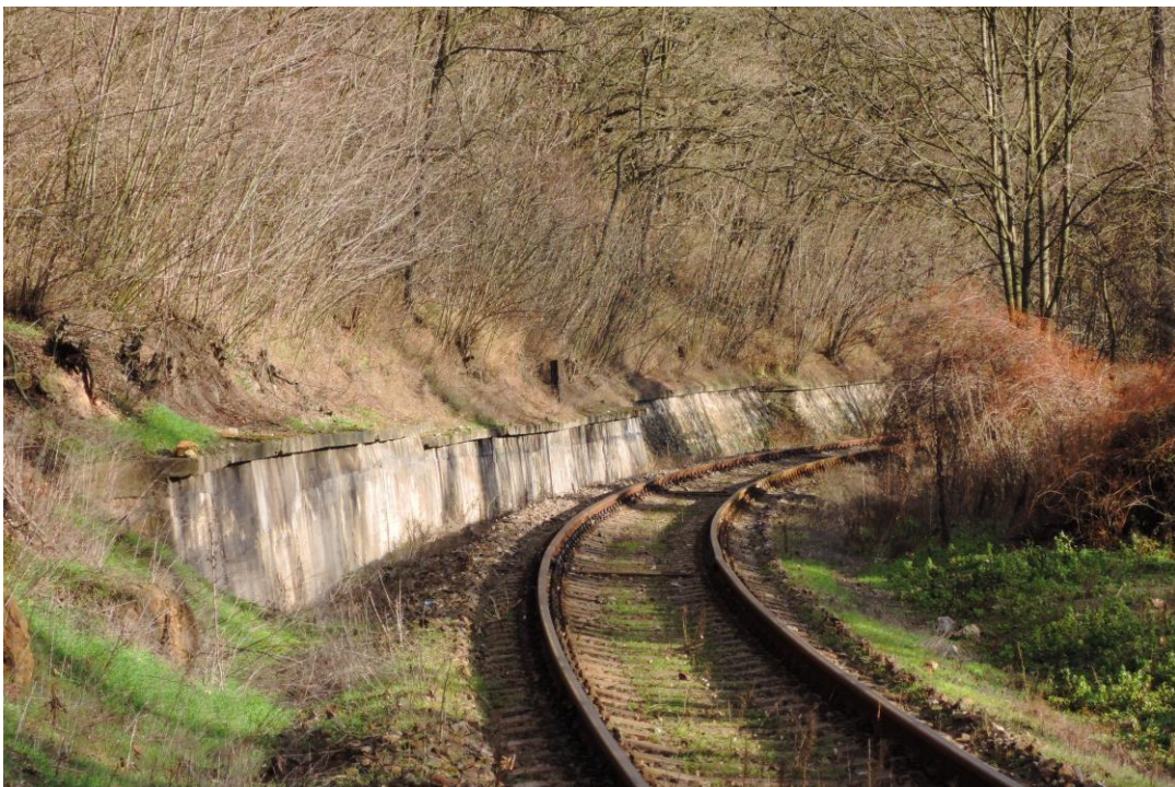
oblouk R = 305 m se zárubní zdí, kde začínají úpravy trati 121 ve variantě Týnec
