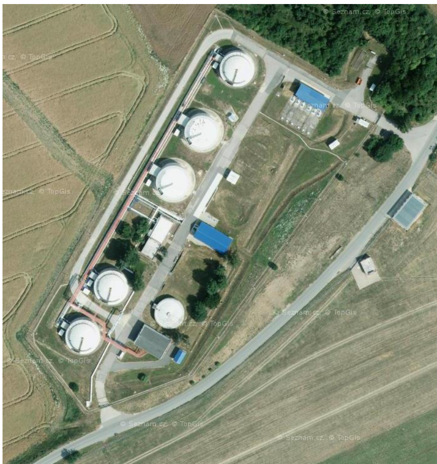
Obrázek 5.3 - Satelitní snímek Centrálního skladu LPH na letišti Václava Havla Praha [MP1]
