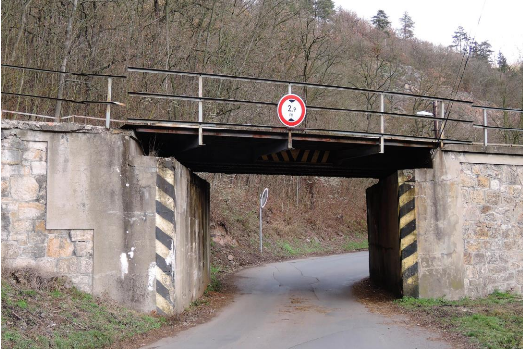
most v ev. km 38,817 přes silnici II/101 se sníženou podjezdnou výškou
