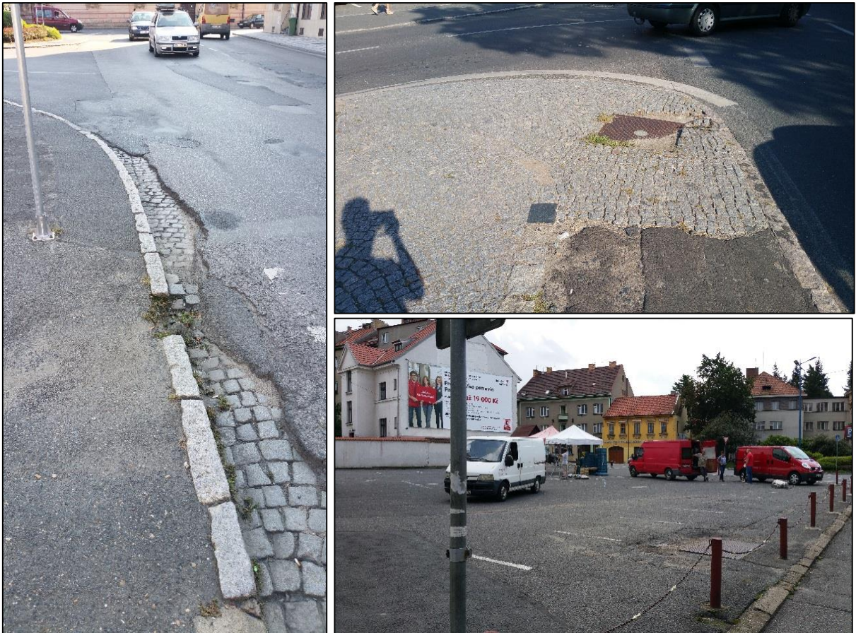
Obr. 18 – Porucha vozovky (ul. Ivana Olbrachta), nekvalitní povrch chodníku (ul. Kralovická) a současný stav parkoviště
