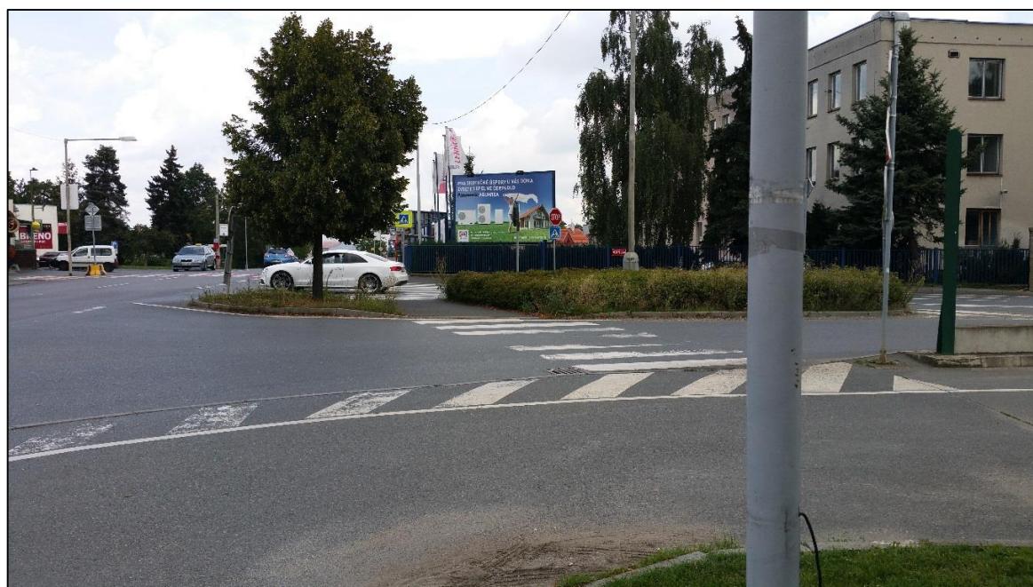
Obr. 11 – Neoznačená autobusová zastávka (ul. Pražská) a špatně řešené přechody na křižovatce (ul. Pražská a Průmyslová)
