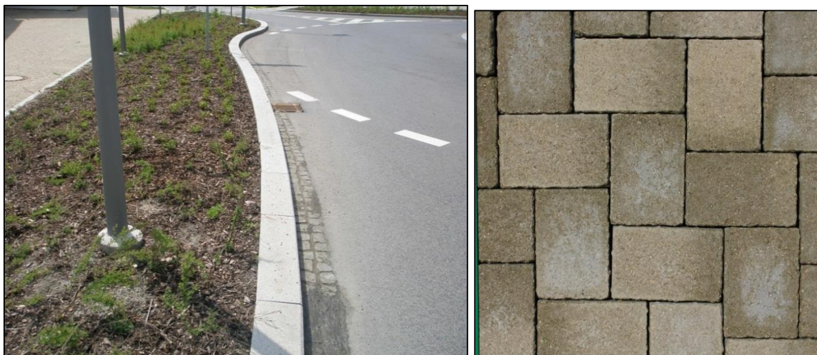
Obr. 34 – Obruba OP a zámková dlažba [19,20]
