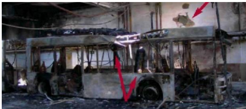
Obrázek č. 3: Mimořádná událost CNG, Německo, 2003 (Zdroj: [40])
