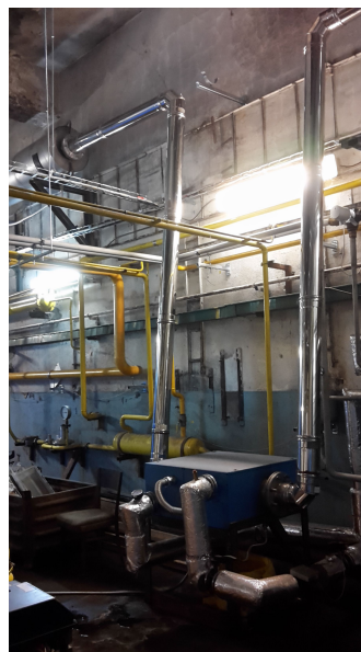
Obrázek 4.4. Ukázka možnosti vést spalinovod v libovolném směru. Autor Vlastimil Černý
