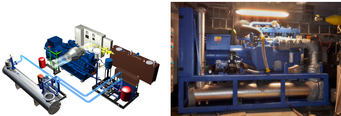
Obrázek 3.2. Ukázka stavebnicové KGJ vlevo a modulové KGJ bez krytu vpravo, autor Tedom a.s. 1)
