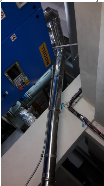
Obrázek 4.4. Ukázka možnosti vést spalinovod v libovolném směru. Autor Vlastimil Černý
