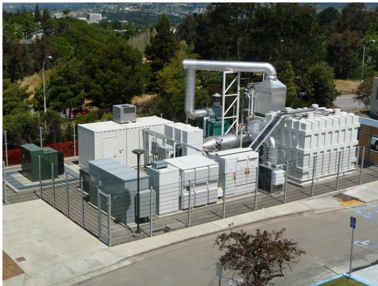
Obrázek 2.7. Ukázka palivového článku DFC@1500 EU firmy FuelCell Energy Solutions 1)
