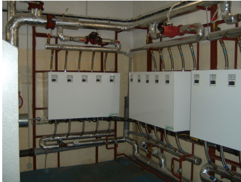
Obrázek 5.4. Kotelna s elektrokotli Kopřiva 3 jednotky o výkonu 180 kW, zdroj Kopřiva Praha s.r.o. 1)
