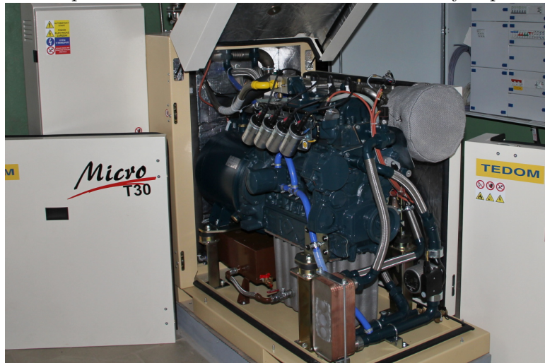
Obrázek 2.8. Ukázka jednotky Tedom Micro T30 s 30 kW elektrického výkonu. Foto Vlastimil Černý
