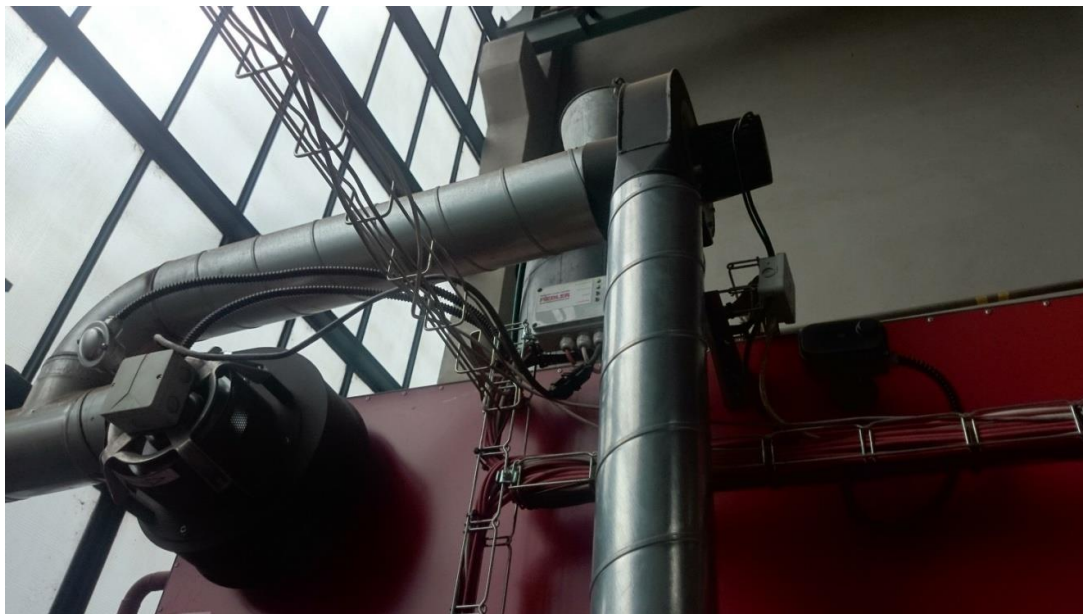
Obr. 13 - Hlavní odtahový ventilátor a recirkulační ventilátor
