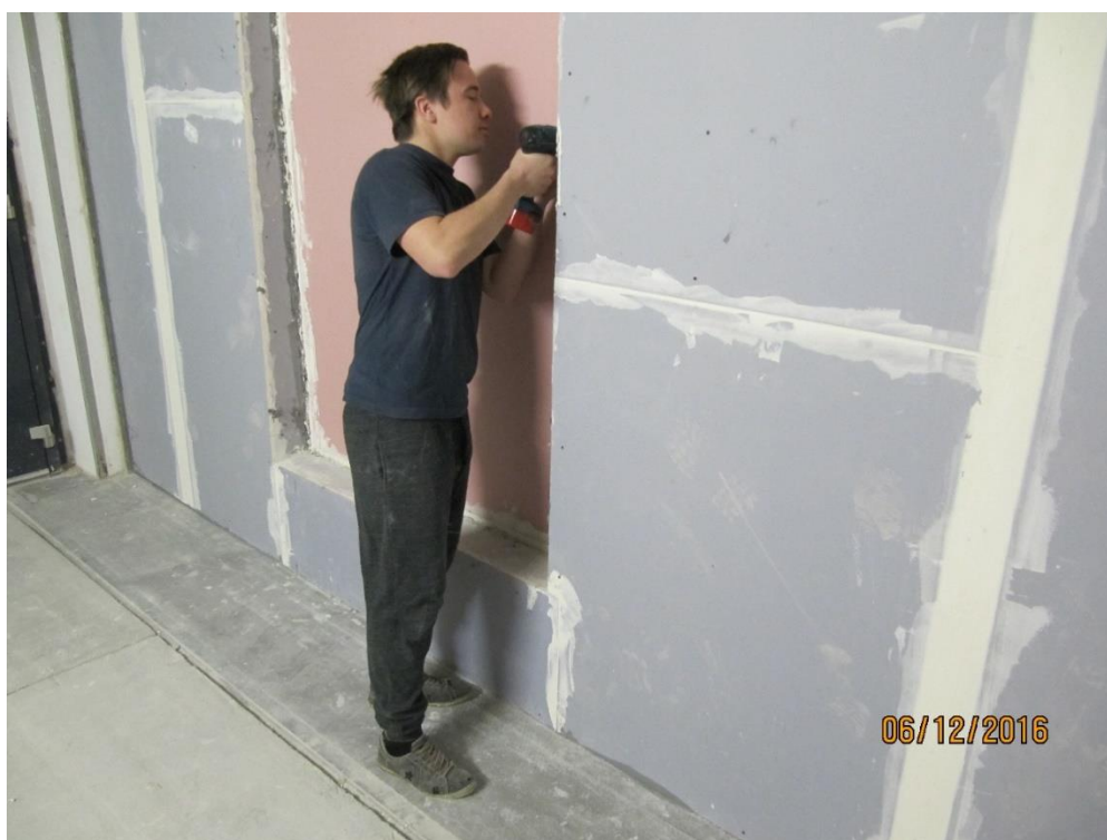
Obr. 6.15 – Aplikování sádkartónářských vrutů do konstrukce
