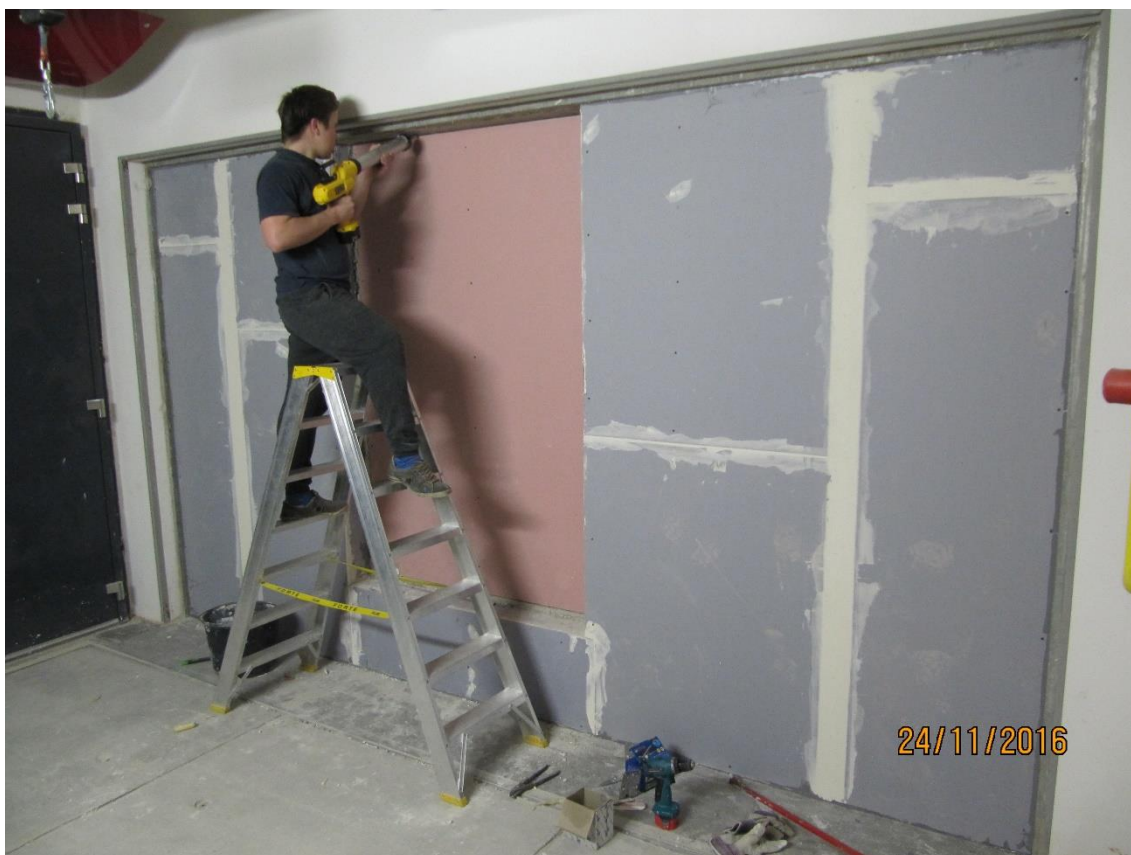
Obr. 6.1 – Aplikování tmelu na zkoušenou konstrukci
