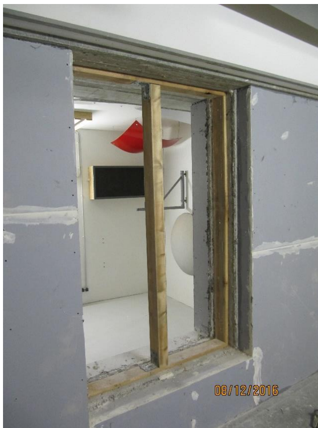
Obr. 6.14 – Dřevěný rám zkoušené konstrukce
