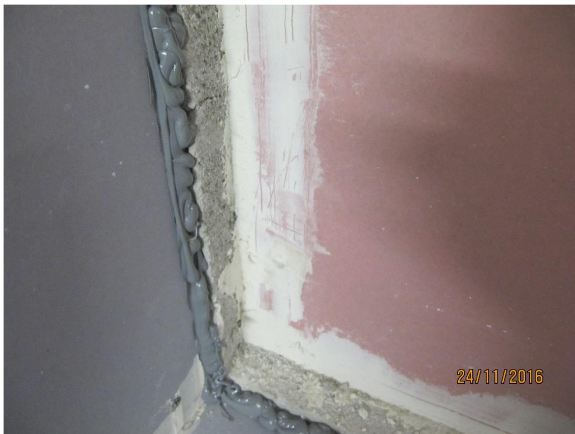
Obr. 6.19 – Šedý pružný tmel a bílý tmel Knauf Uniflot
