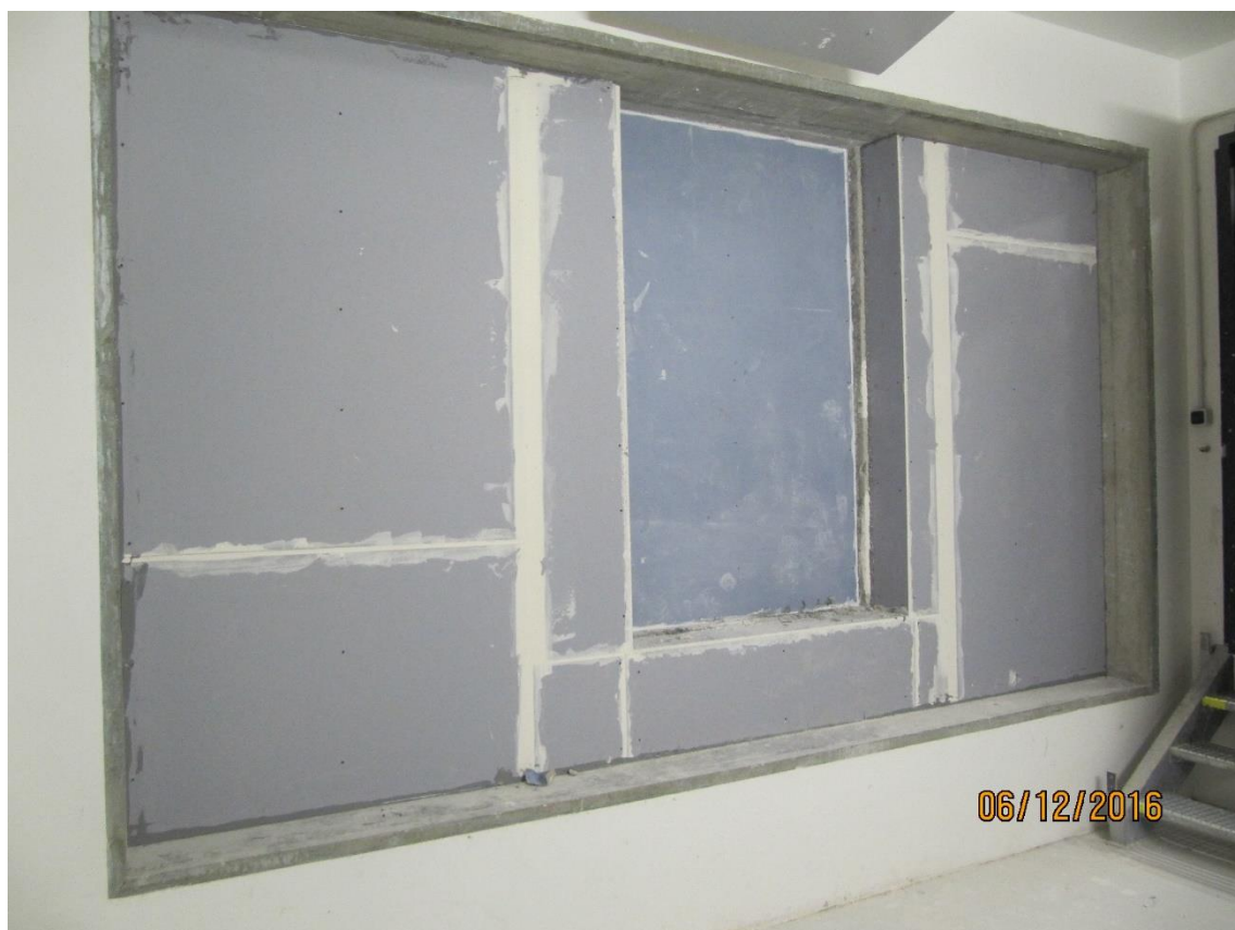
Obr. 6.18 – Mezikomorová stěna se zkoušenou lehkou konstrukcí
