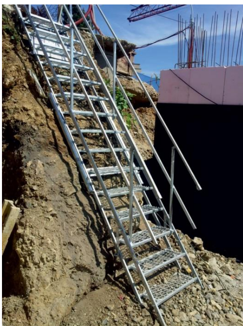
Obr. č. 5: mobilní schodiště SCARSERV SafeStep [zdroj internet]
