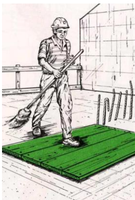
Obr. č. 23: Názorná ukázka zabezpečení otvorů [zdroj internet]
