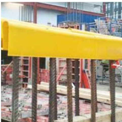
Obr. č. 8: Ochranný prvek NEVOSAFE PLUS [zdroj internet]
