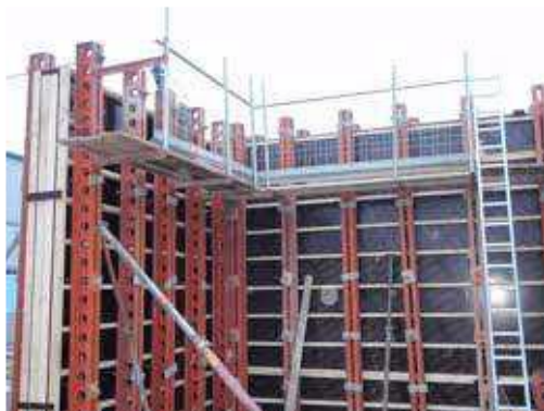
Obr. č. 11: Pracovní lávka pro svislé bednění [zdroj internet]
