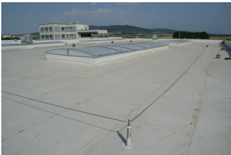
Obr. č. 16: Ilustrační systém vodícího lana TopSafe [zdroj internet]
