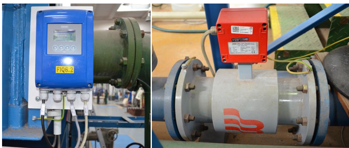
Foto 7.6 Průtokoměr Krohne - žlab A (vlevo) a průtokoměr Badger Meter - žlab B (vpravo)
