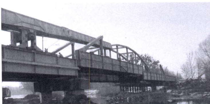
Obr.8: Demolice původního mostu
