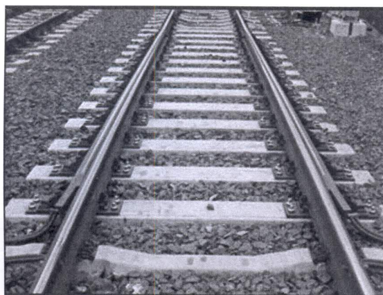
Obr.15: Kolejové dilatační zařízení
