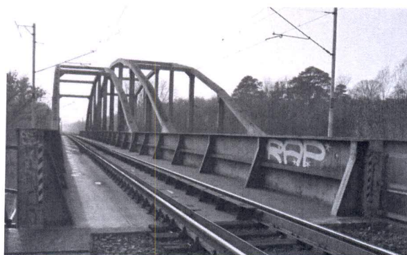
Obr.7: Pohled na železniční svršek původního mostu
