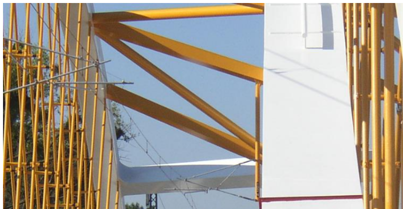
Obrázek 18: Pohled na ztužení oblouků hlavního nosníku NOK2
