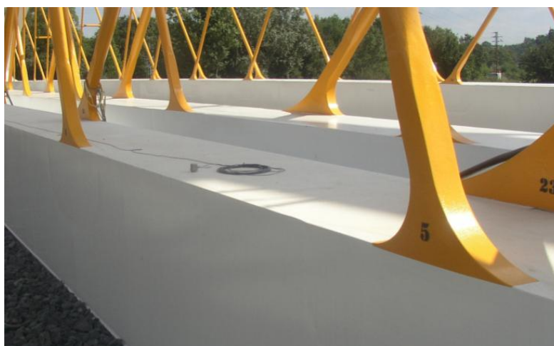
Obrázek 19: Pohled na táhla pravého nosníku NOK1 a levého nosníku NOK2
