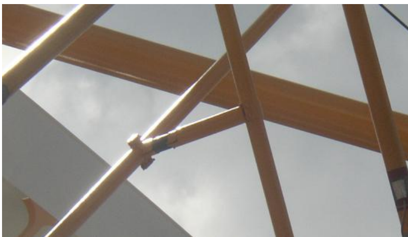
Obrázek 20: Pryžová tlumící spojka křížících se táhel
