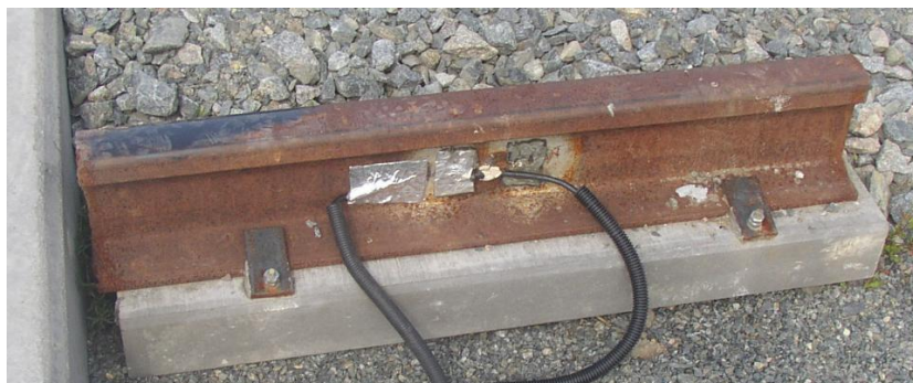
Obrázek 32: Kompenzační kolejnice
