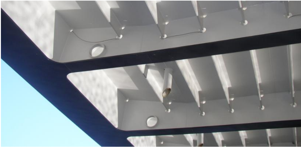
Obrázek 22: Pohled na podélné a příčné výztuhy. Z fotografie je patrný tvar plechu mostovky
