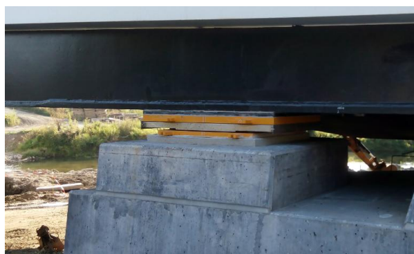
Obrázek 25: Pohled na levé ložisko NOK1 na opěře 01
