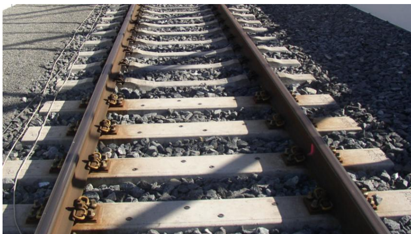
Obrázek 15: Pohled na železniční svršek v místě změny pražců
