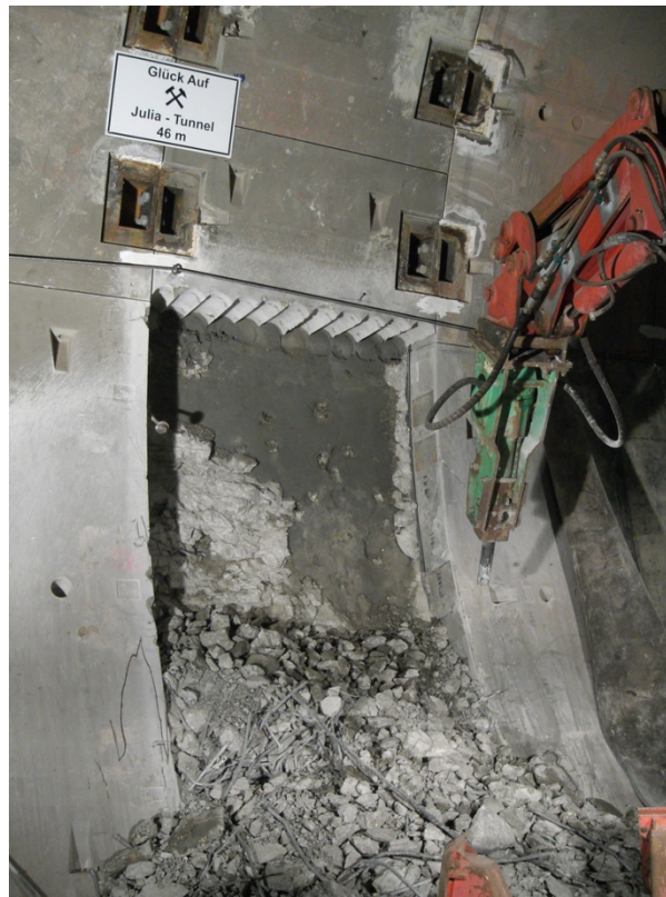
Obrázek 5.10 - demontáž segmentu v místě budoucí propojky [14]
