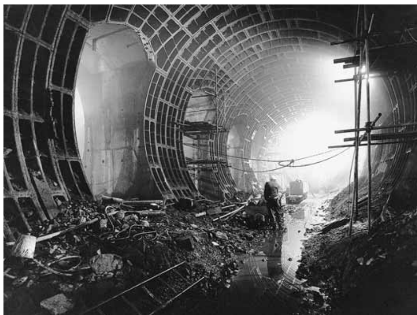
Obrázek 4.1 - prostup ve stanici Staroměstská [2]
