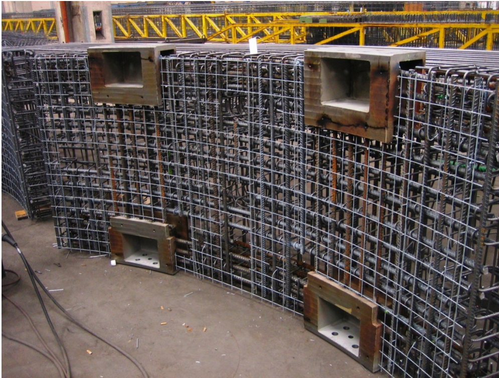
Obrázek 5.9 - armokoš segmentu s ocelovými kapsami [14.]
