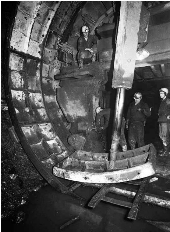
Obrázek 2.3 - erektor při ukládání segmentu [2]
