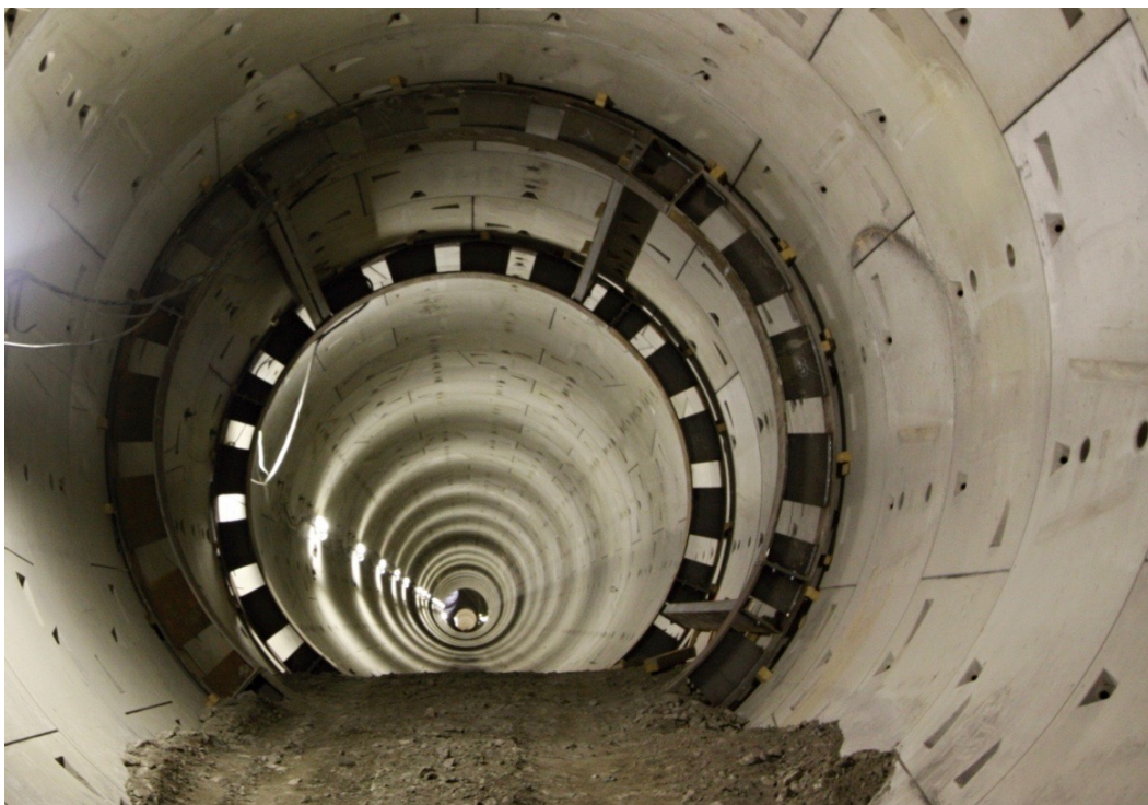
Obrázek 5.1 - kruhový rozpěrný rám - prodloužení linky metra A [9]
