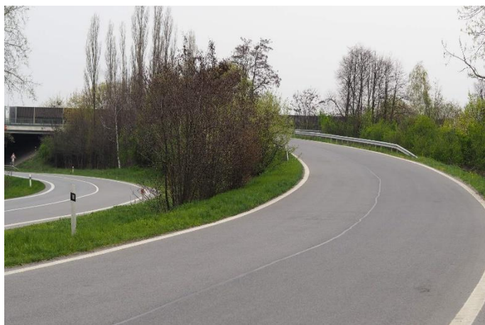
Foto 4 – Přímá větev od I/38 na D10 (vpravo), podjezd pod dálnicí (vlevo)
