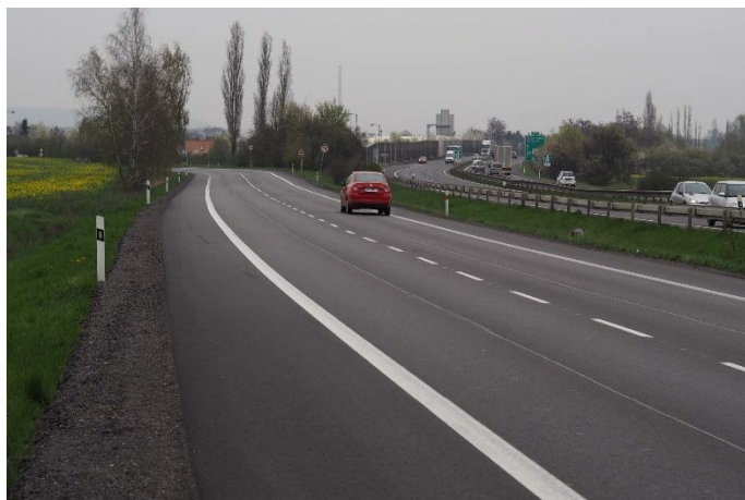
Foto 2 – Souběh silnice I/16 a dálnice D10
