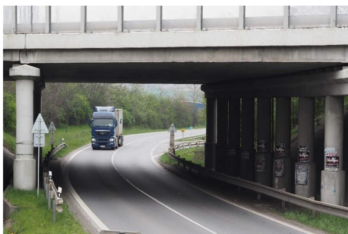
Foto 6 – Podjezd pod dálnicí, styk silnic I/16 a I/38
