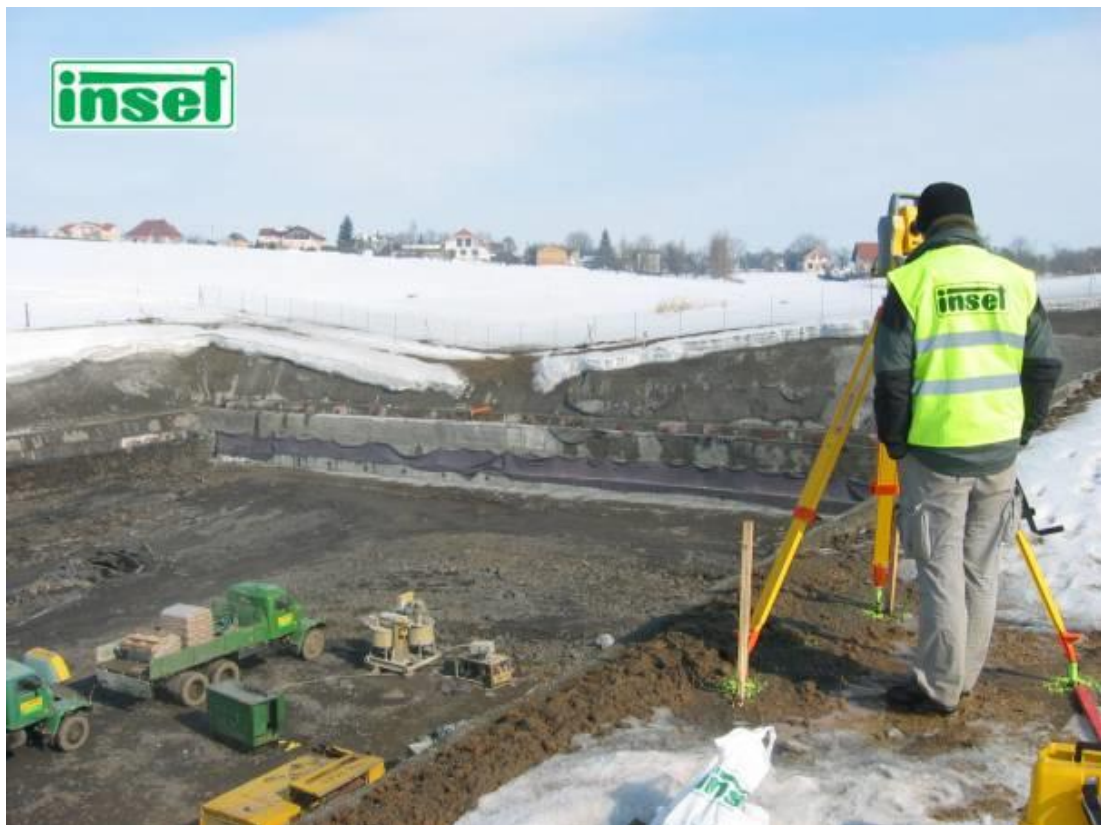
Obr. 3.1 Monitoring stavební jámy geodetickými metodami (Monitoring stavebních jam, 2016)
