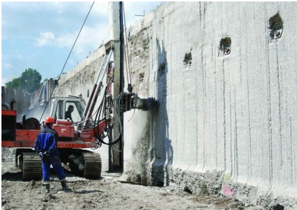
Obr. 2.27 Frézování povrchu monolitických podzemních stěn (Zakládání staveb, a. s., 2016)
