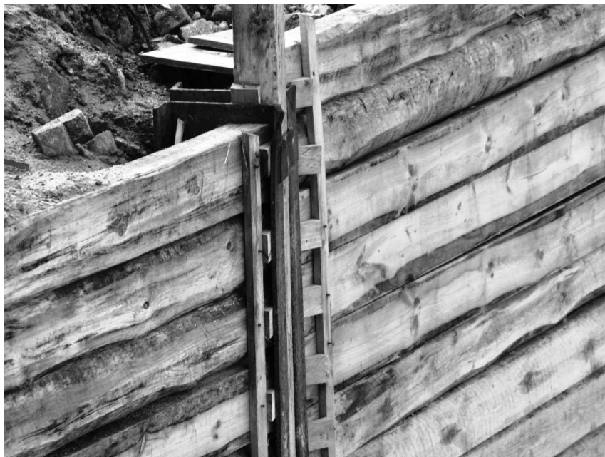
Obr. 2.8 Záporové pažení s klíny (Barták a Pruška, 2011)
