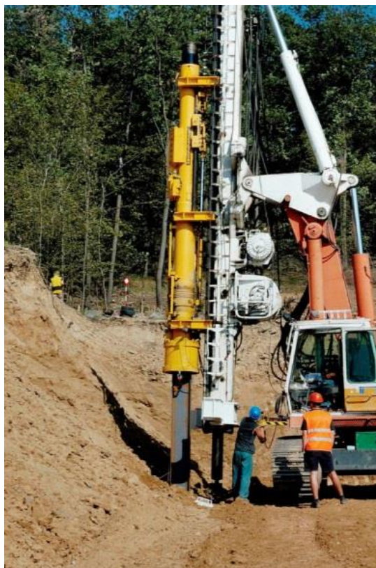
Obr. 2.6 Beranění zápor zajišťujících budoucí stavební jámu (Zakládání staveb, a. s., 2016)
