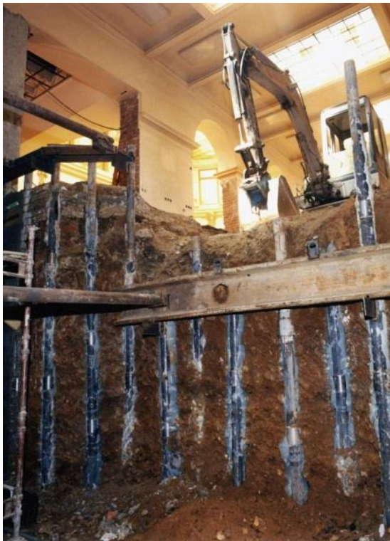
Obr. 2.12 Pohled na částečně odtěženou mikrozáporovou stěnu (Zakládání staveb, a. s., 2016)
