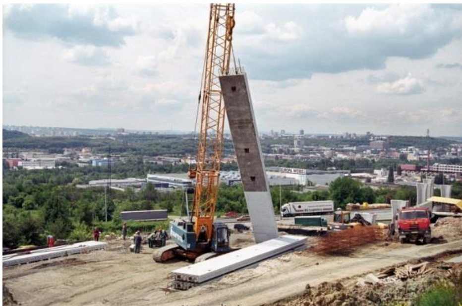
Obr. 2.28 Prefabrikované panely podzemní stěny (Zakládání staveb, a. s., 2016)
