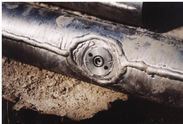
Obr. 2.37 Detailní pohled na monitor s tryskou injekční kolony (metoda M2) (Zakládání staveb, a. s., 2016)
