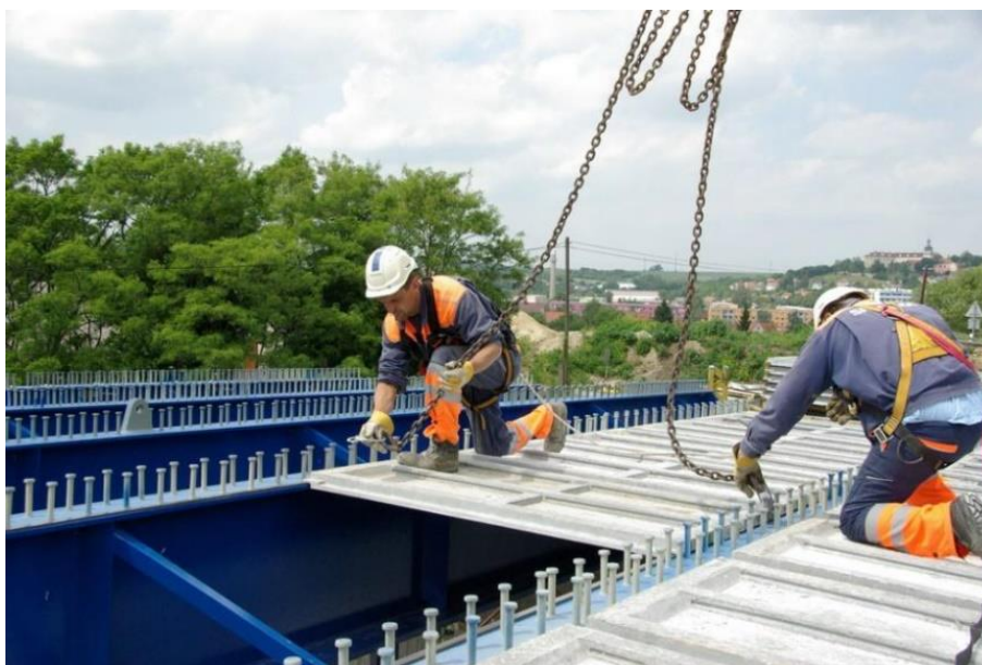
Obrázek 9: Montáž desek ztraceného bednění. Převzato z [11].
