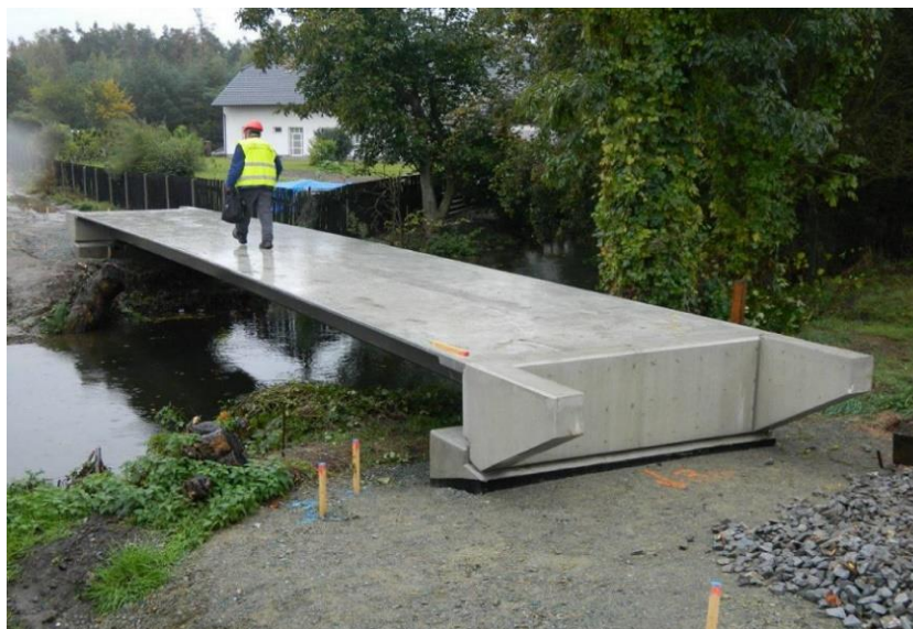
Obrázek 14: Osazení lávky z UHPC u Opatovic. Převzato z [17].
