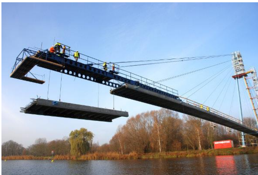
Obrázek 11: Montáž segmentů na lávce v Čelákovících. Převzato z [16].
