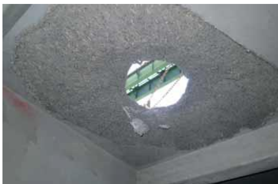
Obrázek 12: Propíchnutí desky. Převzato z [16].
