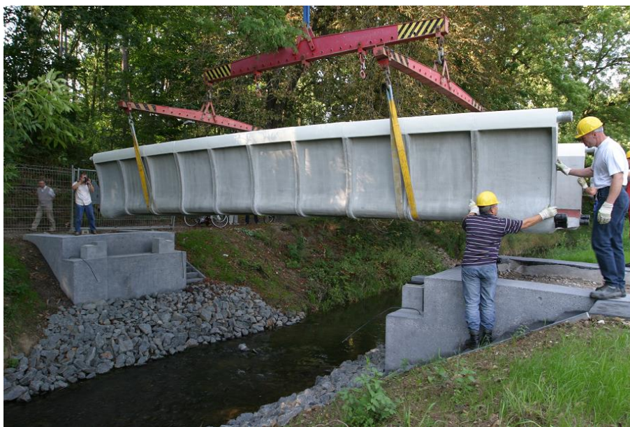
Obrázek 28: Montáž lávky Döllnitz Creek. Převzato z [20].
