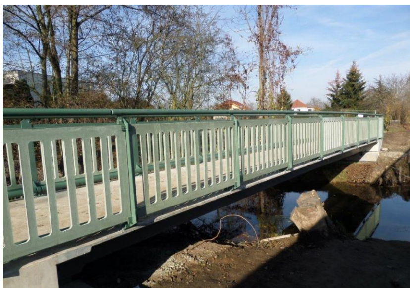
Obrázek 15: Kompletní lávka se zábradlím z UHPC. Převzato z [17].
