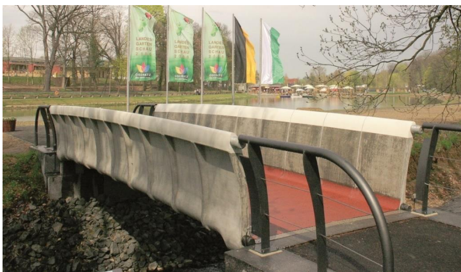
Obrázek 23: Lávka přes řeku Döllnitz. Převzato z [20].
