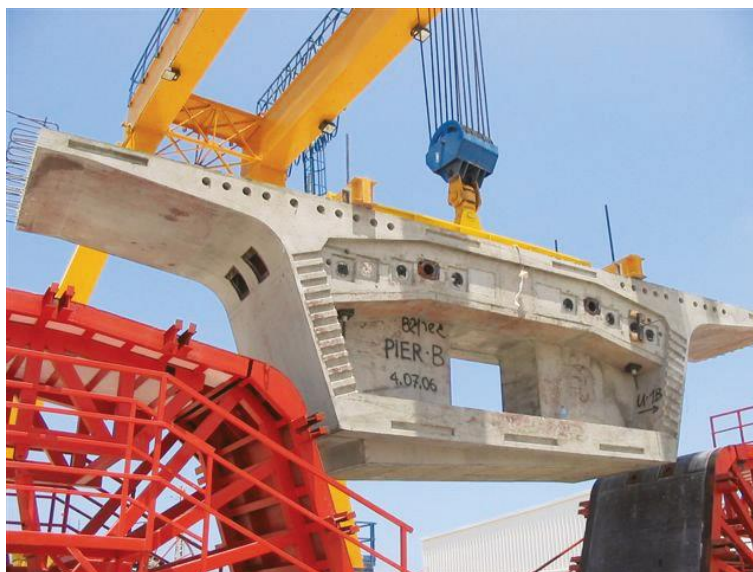
Obrázek 16: Mostní segment. Převzato z http://www.asbi-assoc.org/images/imageGallery/58/image2.jpg
