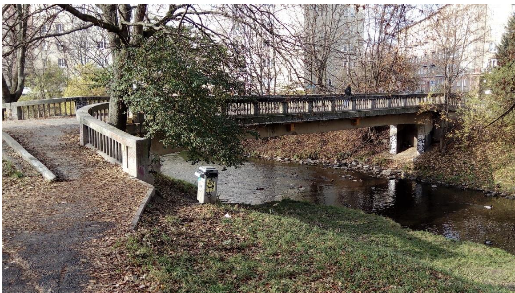
Obrázek 25: Pohled na současnou lávku. Foto autora.
