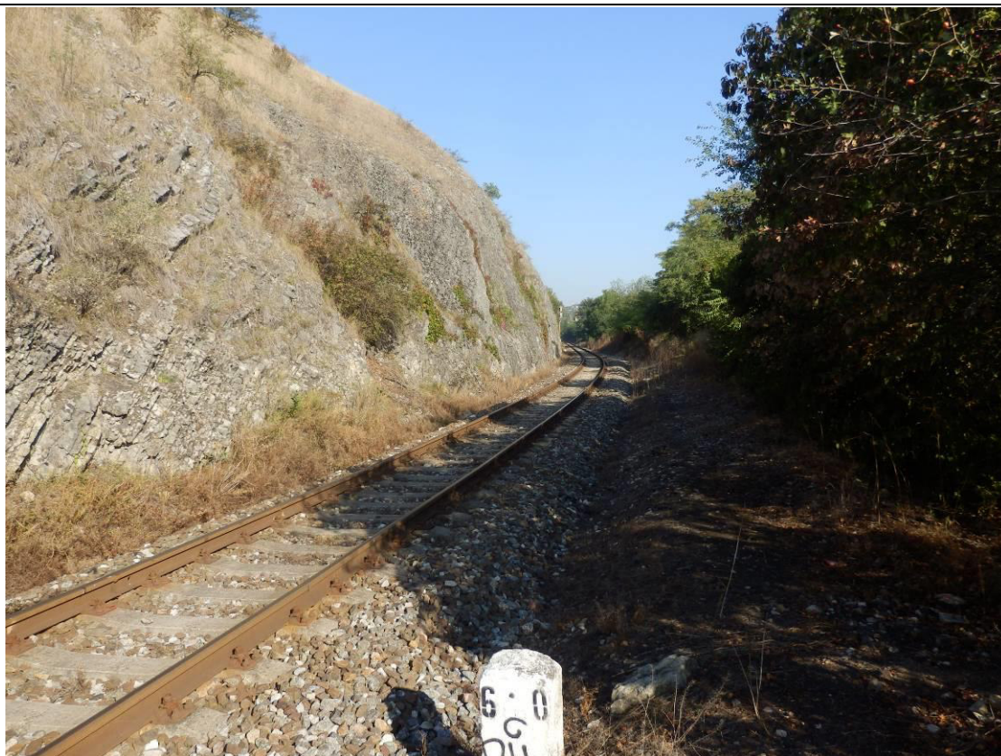
Obr. 7 Skalní masiv v km 6,050
