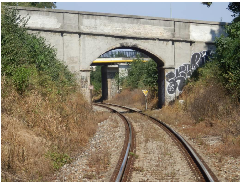
Obr. 1 Silniční nadjezd v km 2,186 (zpětný pohled)
