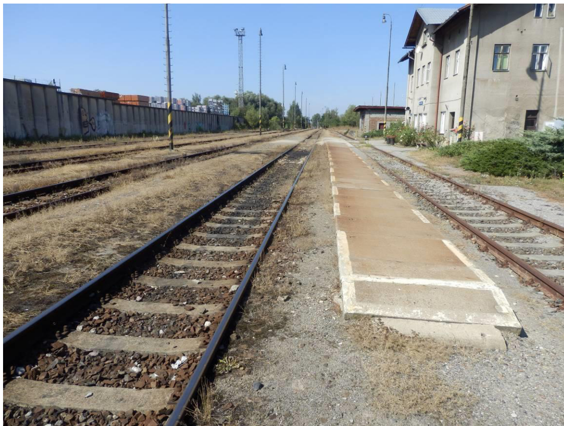
Obr. 19 Kolejiště v ŽST Praha-Zličín s nástupištěm, km 15,330
