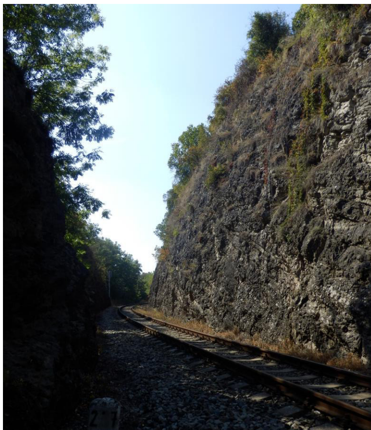
Obr. 2 Skalní zářez v km 2,700
