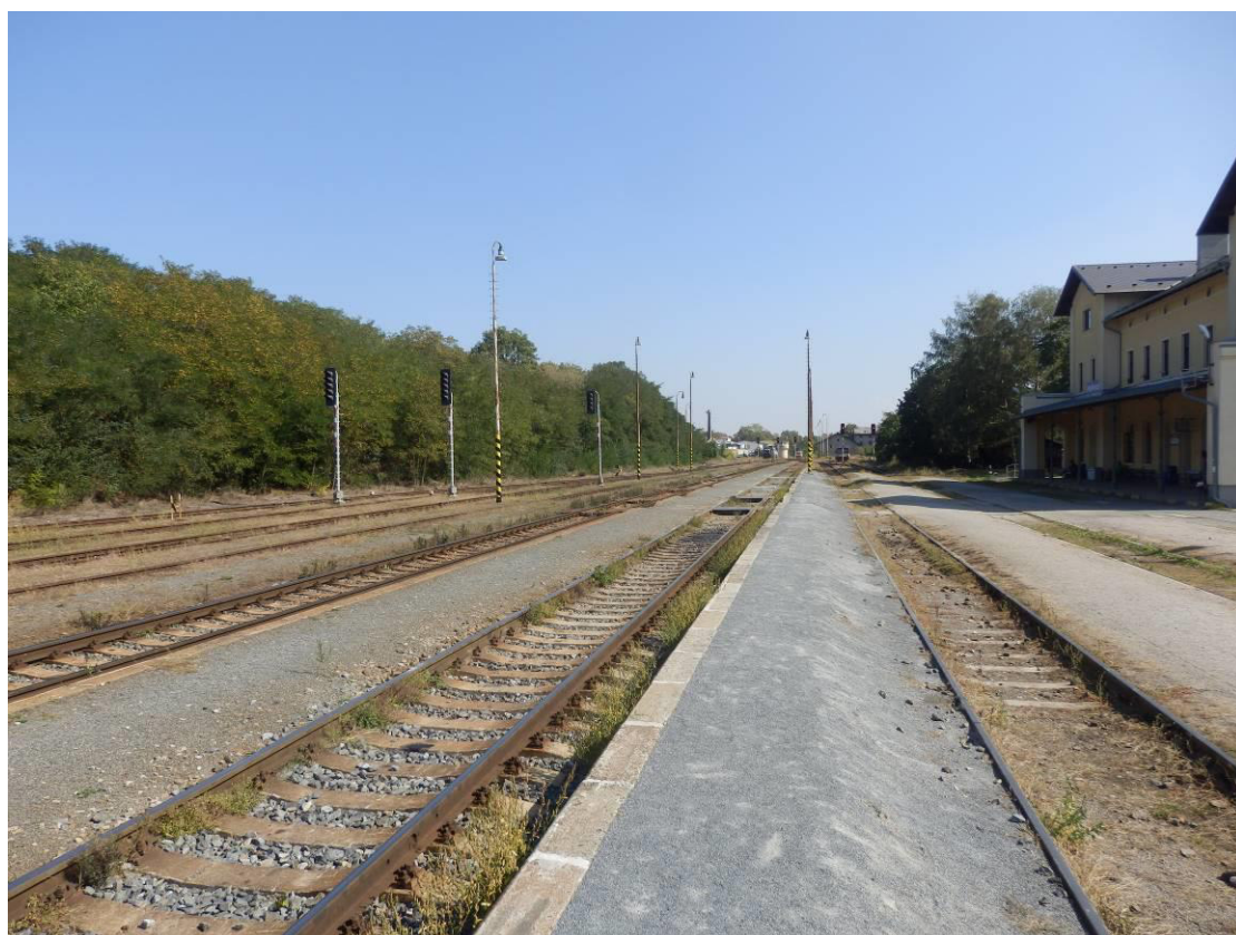
Obr. 24 Prostor kolejiště před výpravní budovou v ŽST Hostivice, km 19,618 = 14,809
