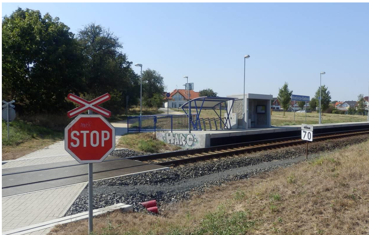
Obr. 23 Železniční zastávka Hostivice-Sadová s přejezdem pro cyklostezku, km 18,140
