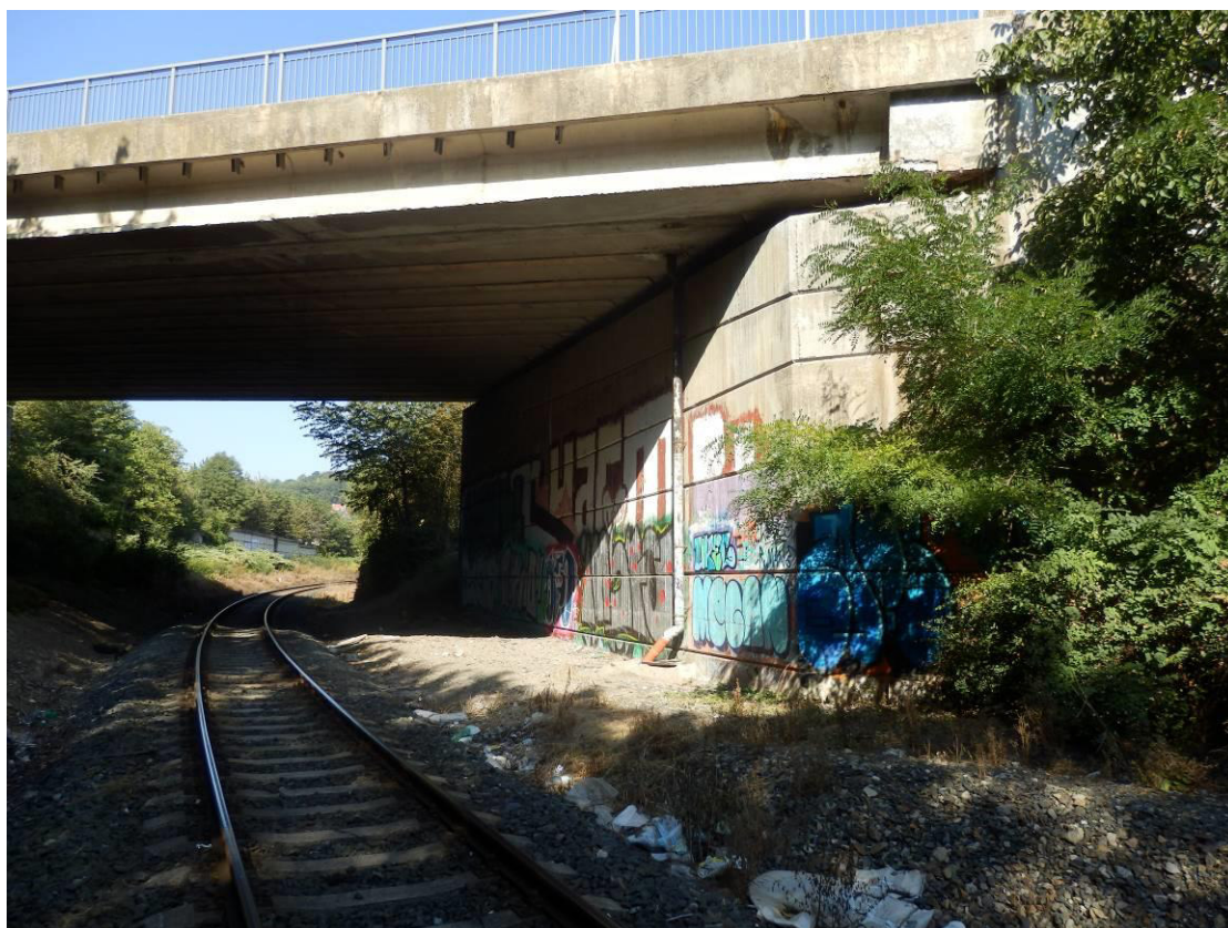
Obr. 10 Nadjezd ul. Radlická, km 8,628
