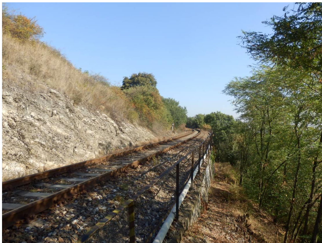
Obr. 6 Opěrná stěna ve skalním odřezu, km 5,700
