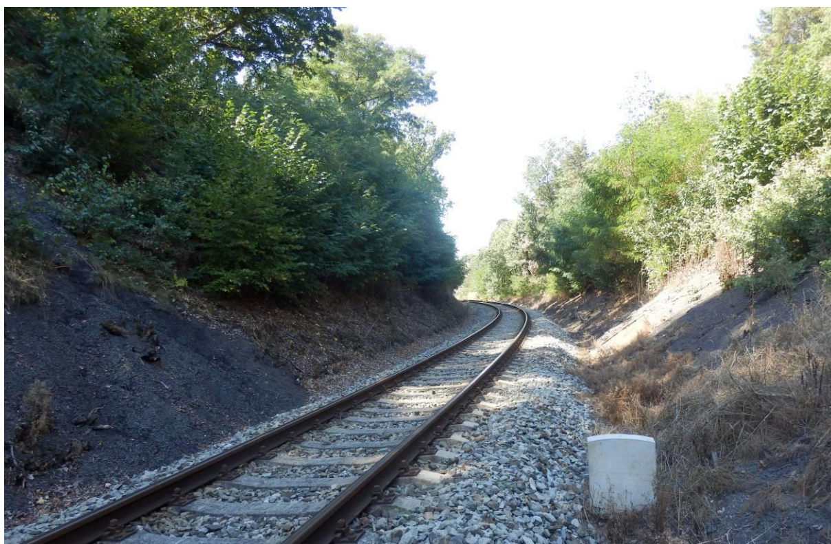
Obr. 17 Zážez (15 metrů hluboký) v navětralé skalní hornině, PP Motolský ordovik, km 12,700
