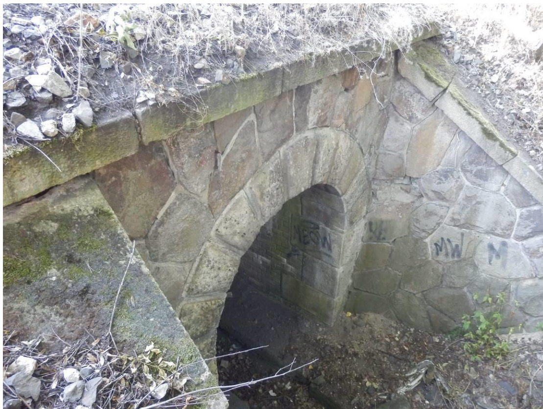
Obr. 21 Kamenný klenutý propustek km 17,442
