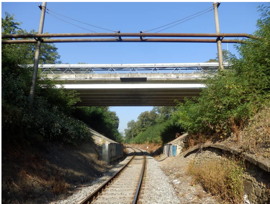
Obr. 8 Silniční nadjezd v km 6,763
