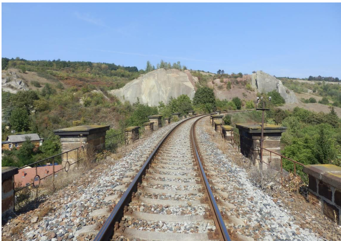
Obr. 4 Druhý oblouková most přes Prokopské údolí, km 4,355
