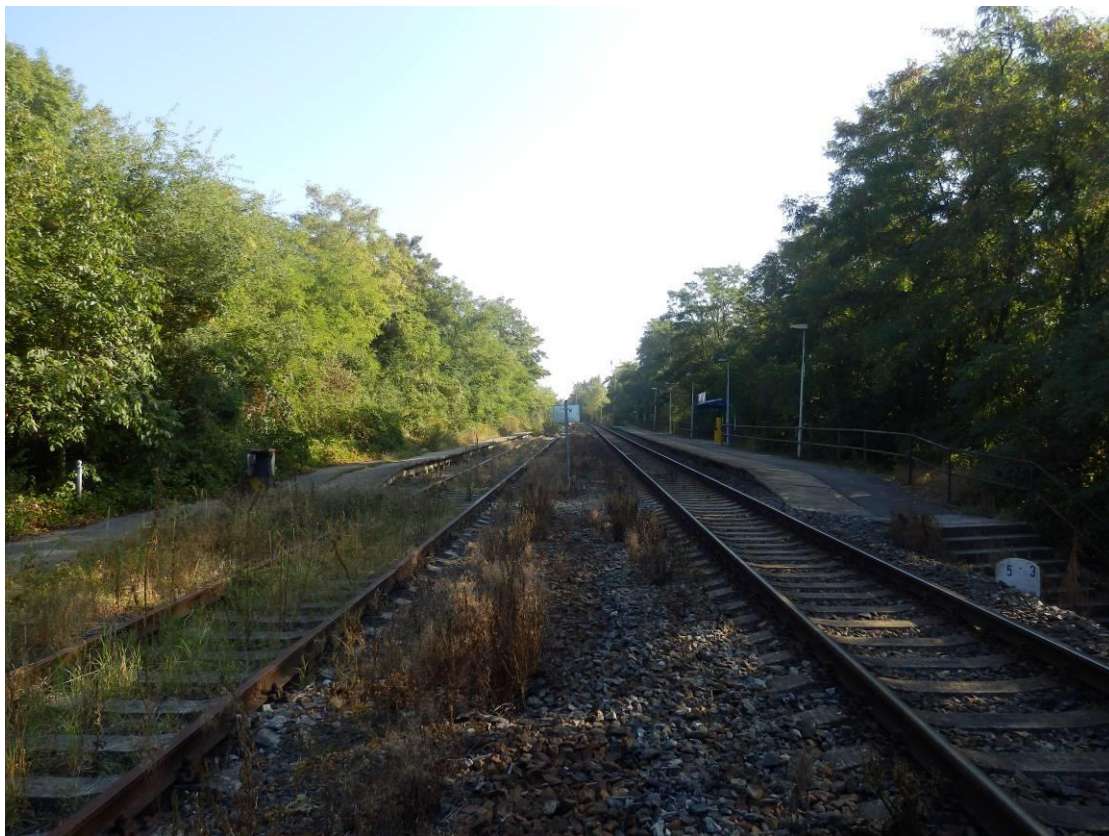
Obr. 5 Výh. Žvahov, kolej i nástupiště v předjízdě koleji zarůstají bylím a dřevinami (km 5,300)
