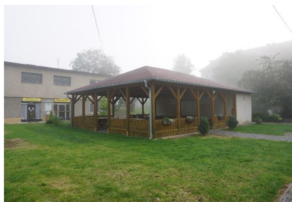
Obr. 17: Objekt pro venkovní výuku
