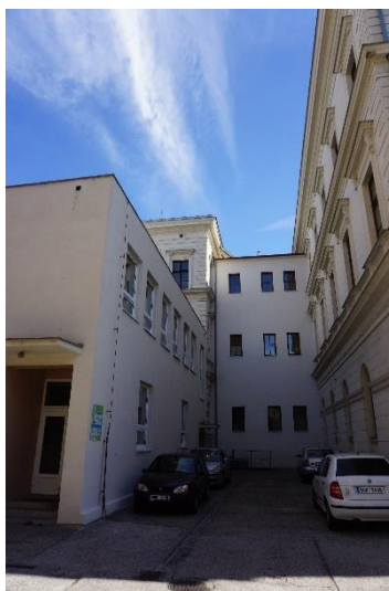
Obr. 22: Prostor pro umístění nádrže (v zadní části místnost z obr. 15)
