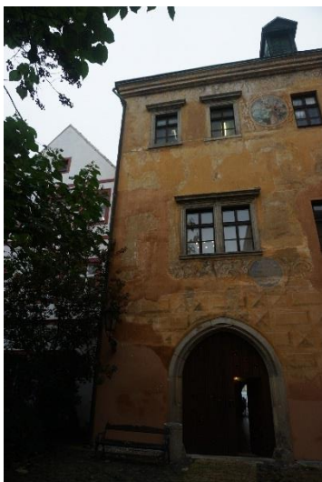
Obr. 44: Pohled na budovu ze dvora
