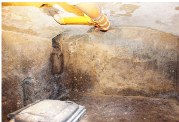
Obr. 57: Sklepní prostory pod toaletami.
