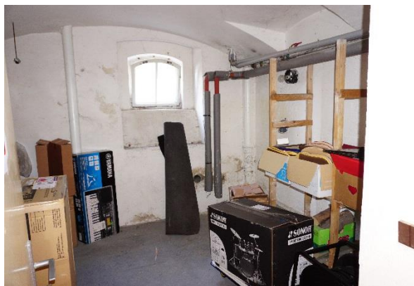
Obr. 40: Místnost vhodná pro umístění technologie.
