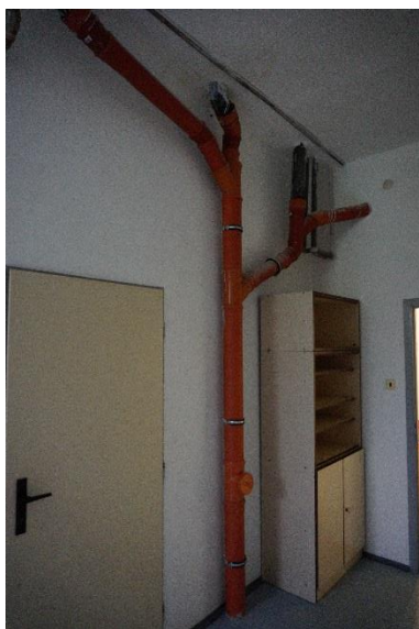
Obr. 30: Místnost pro technologii (v 0. a I. podlaží nad místností se nachází toalety) (dešťový svod B )
