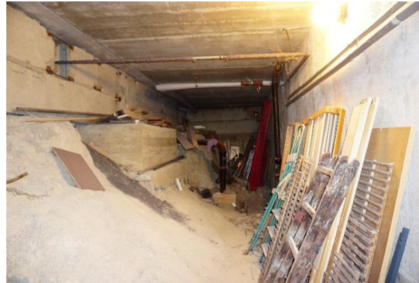
Obr. 34: V těchto místech asi umístěny dešťové svody v blízkosti základů (svody B a C)
