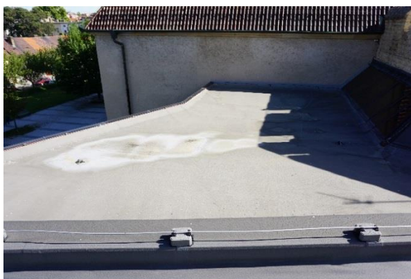
Obr. 64: Dešťové svody ze střechy budovy nad hlavním vchodem.
