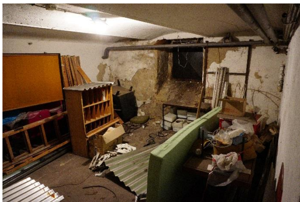
Obr. 61: Sklepní místnost situovaná pod dámskými záchody
