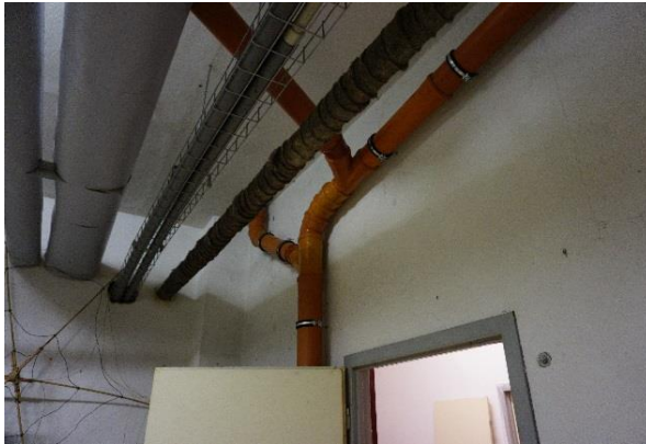
Obr. 33: Dešťový svod A v místnosti AN
