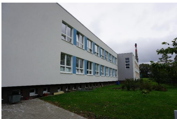
Obr. 27: Podsklepení prvního stupně
