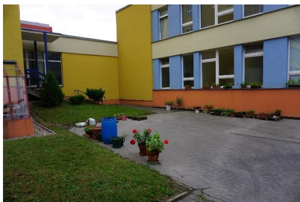
Obr. 31: Umístění nádrže AN-vlevo vchod a budova II. stupně, vpravo budova kroužků
