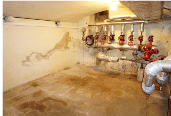
Obr. 42: Místnost s uzávěry teplé vody
