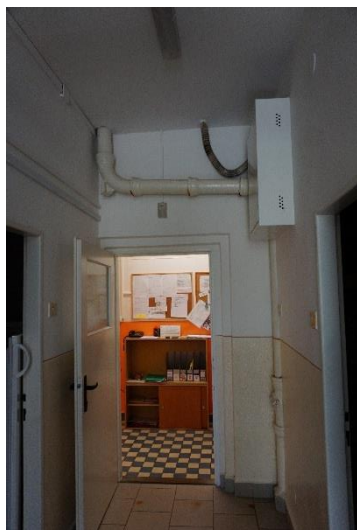
Obr. 10: Vnitřní dešťový svod
