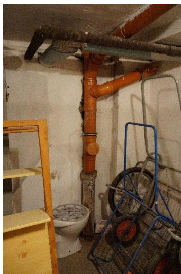
Obr. 5: Kanalizační a pravděpodobně dešťový svod
