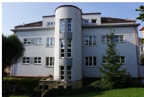
Obr. 2: Okna napravo jsou okna k toaletám.
