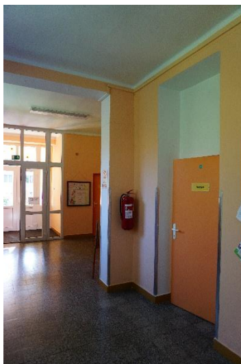
Obr. 4: V této části sloupku je skrytý dešťový svod
