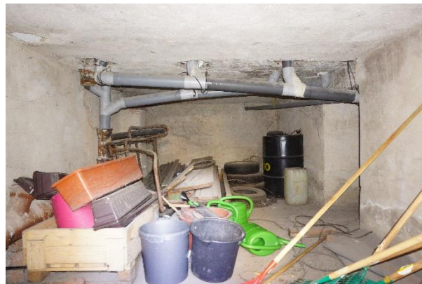
Obr. 21: Sklepní prostor pod toaletami
