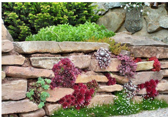
Obrázek 3: Osázená suchá kamenná zeď
