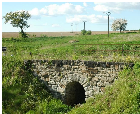
Obrázek 6: Kamenný propustek
