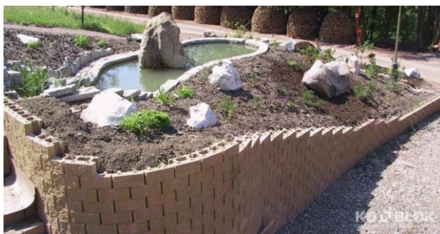
Obrázek 8: Opěrná zeď z tvarovek
