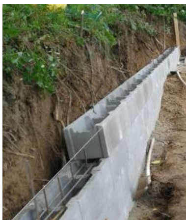
Obrázek 14: Ztracené bednění
