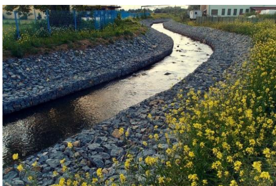
Obrázek 23: Zpevnění břehu gabionem
