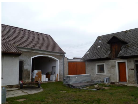
Obr. č. 3 – Pohled na průjezd (S pohled)
