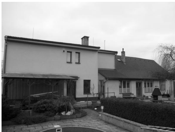
Obr. č. 3 – Severní pohled
