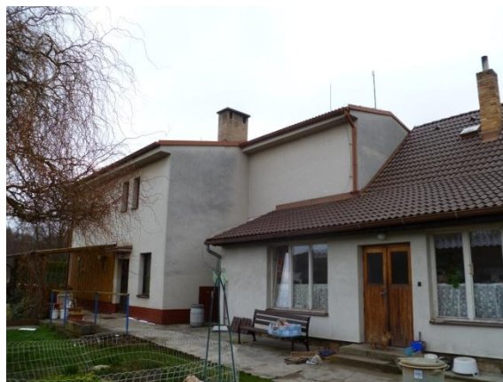
Obr. č. 2 – Pohled na verandu (S pohled)
