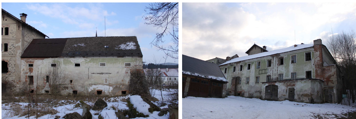
Obr. 16 Pohled na jižní (vlevo budova č. 18) a severovýchodní (vpravo, budova č. 18) část pivovaru; zdroj vlastní
