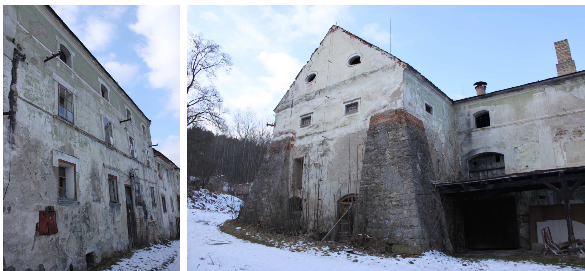
Obr. 21 Východní fasáda pivovaru (vlevo), jižní fasáda s opěrnými pilíři (vpravo); zdroj vlatní
