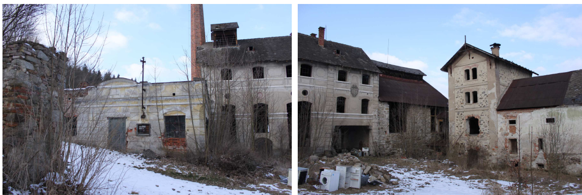
Obr. 15 Pohled na západní části (vlevo, budova č. 20) a severní část (vpravo, budova č. 19) pivovaru; zdroj vlastní
