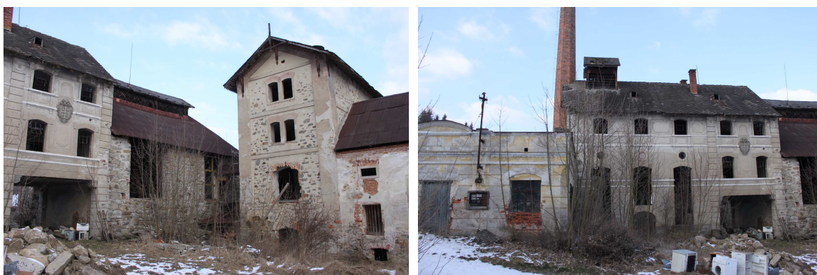
Obr. 22 Fasády-schodišťová věž a sýpka (vlevo), průčelí budov č. 19 a 20 (vpravo); zdroj vlastní
