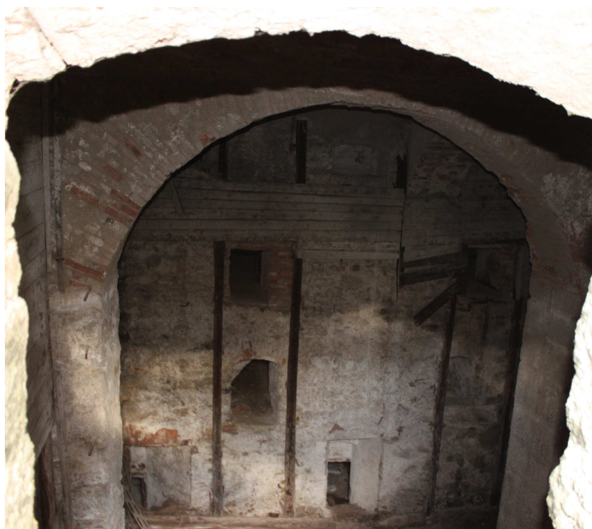
Obr. 10 Pohled do sladovny z úrovně terénu západním oknem; zdroj vlastní
