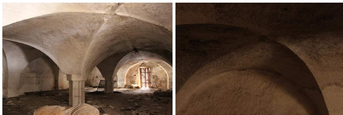
Obr. 26 Hřebínkové kleny v jihozápadní části budovy č. 18; zdroj vlastní
