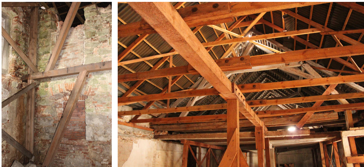
Obr. 23 Provizorní dřevěné konstrukce k zajištění stability porušených stěn a krovů - východní část pivovaru (vlevo), sklady v 3.NP jihozápadní části budovy č. 18 (vpravo); zdroj vlastní
