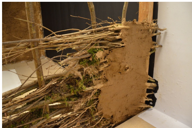
obrazek. nazwa: konstrukcja ściany z drewna i tynku
