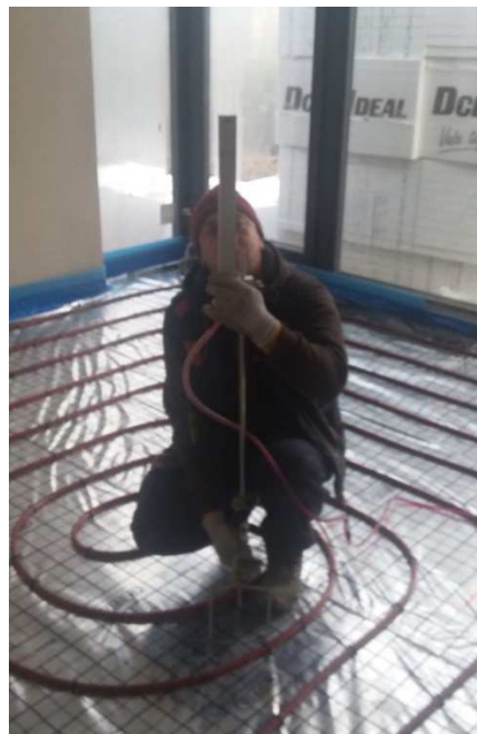
Obrázek 7 – Nastavení výšky nivelačních trojnožek
