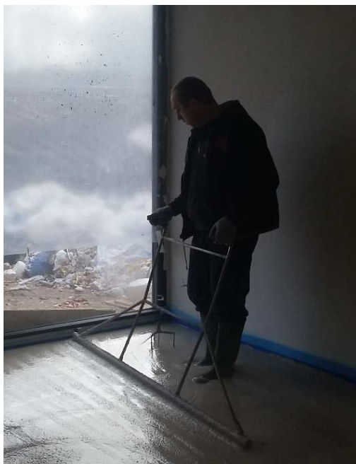
Obrázek 12 – Nivelace povrchu čerstvého potěru
