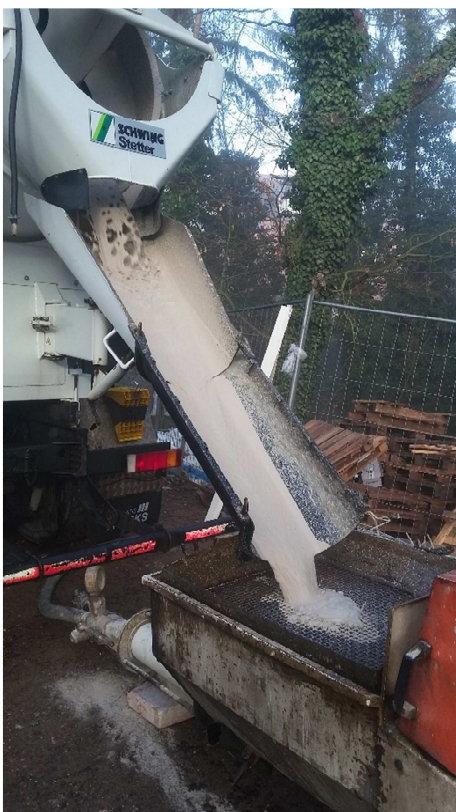
Obrázek 10 – Čerpání potěrové směsi
