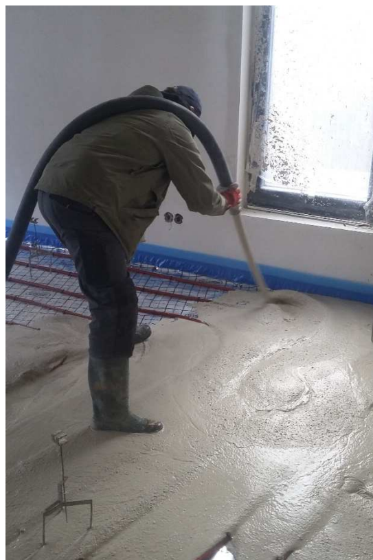
Obrázek 11 – Ukládání čerstvého anhydritového potěru
