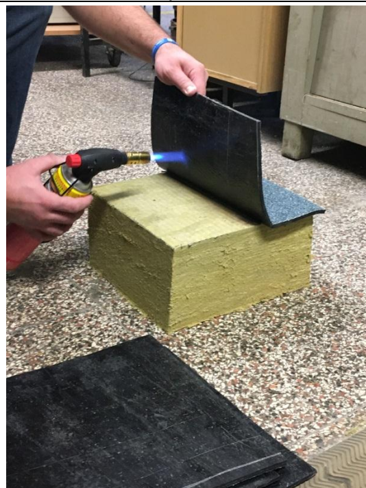
Obr. č. 9: Průběh navařování asfaltového pásu
