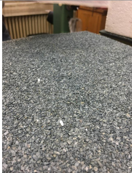
Obr. č. 25: Detail struktury navařeného asfaltového pásu
