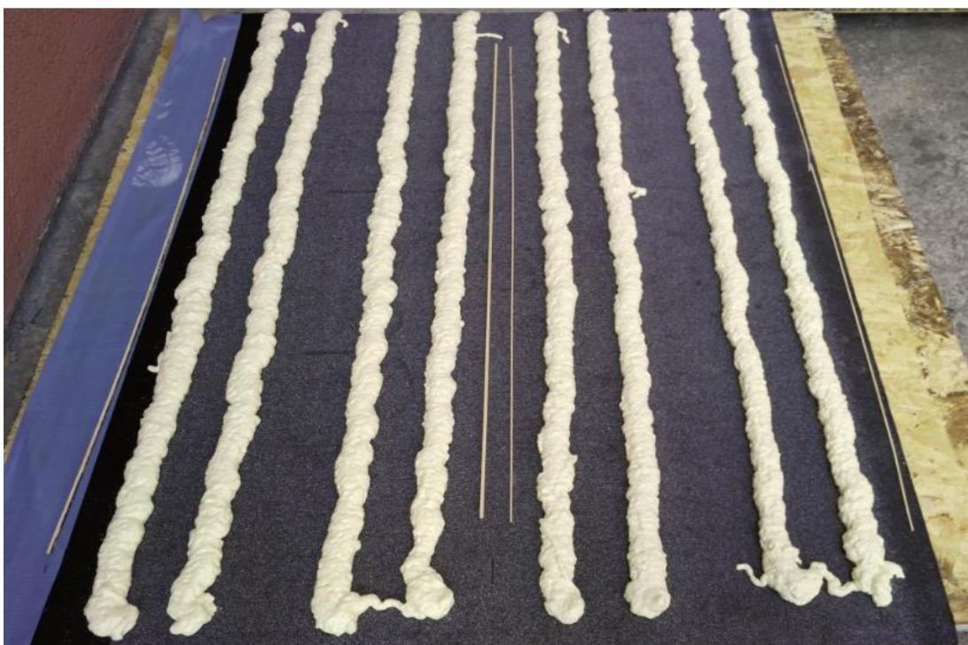
Obr. 16: Rozmístění pruhů lepidla a modelářských hranolků
