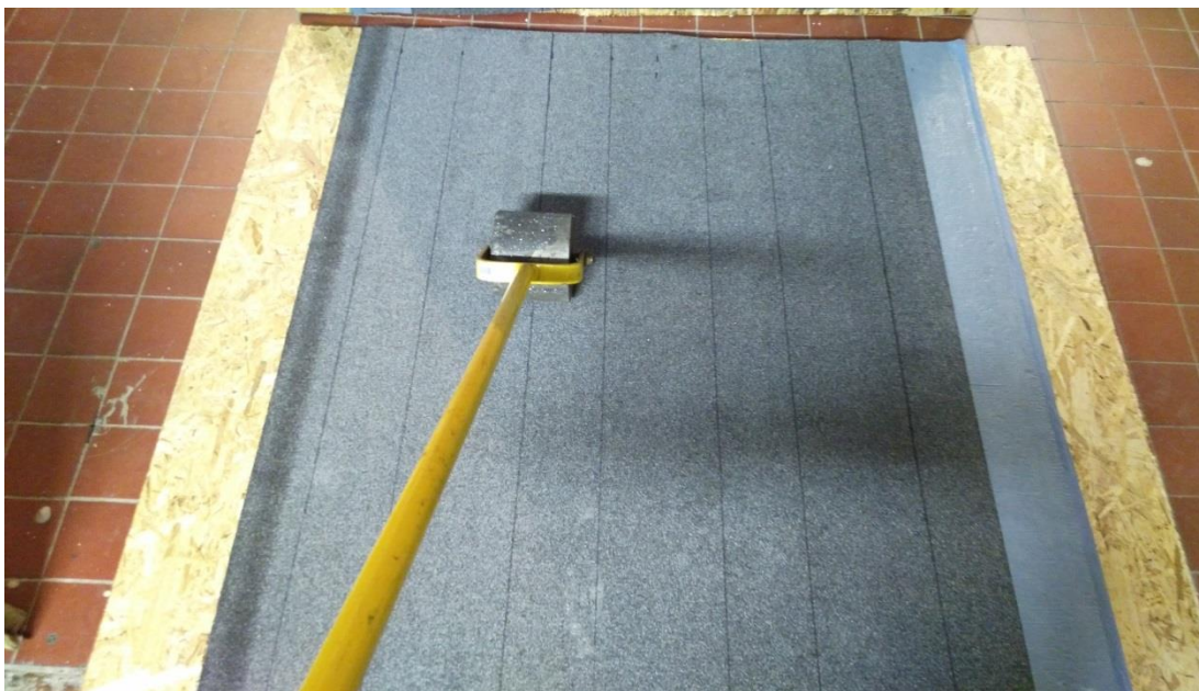
Obr. 15: Válcování samolepicího asfaltového pásu
