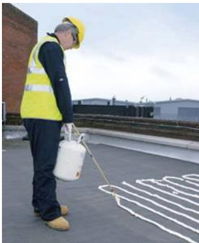
Obr. 3: Nanášení lepidla v tanku STD [11]
