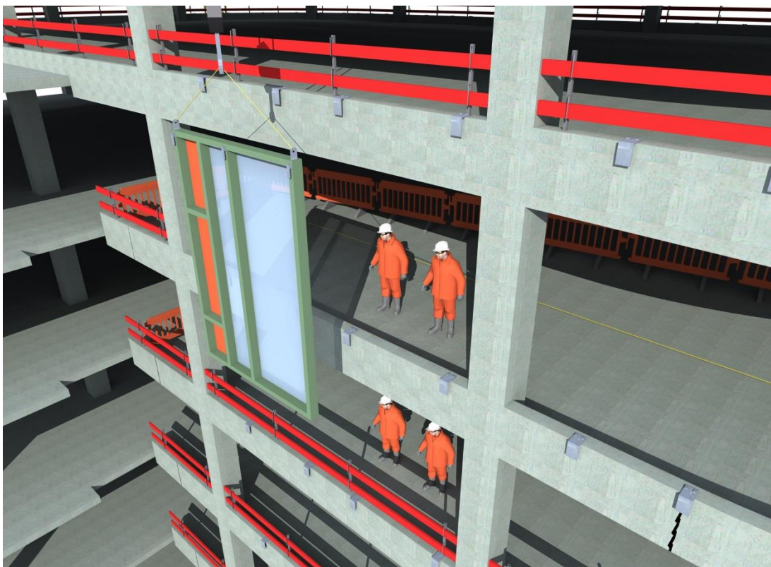
Ilustrace 19 – montáž velkého elementu stacionárním jeřábem: zdroj autor
