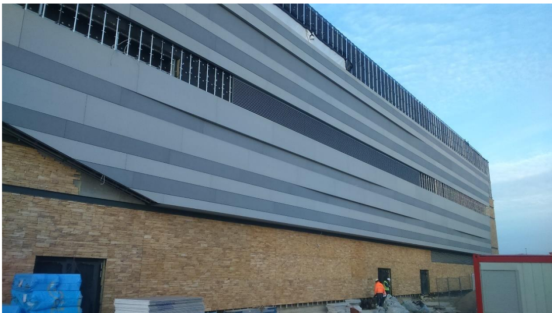
Foto 3.: Pohled na jižní fasádu
