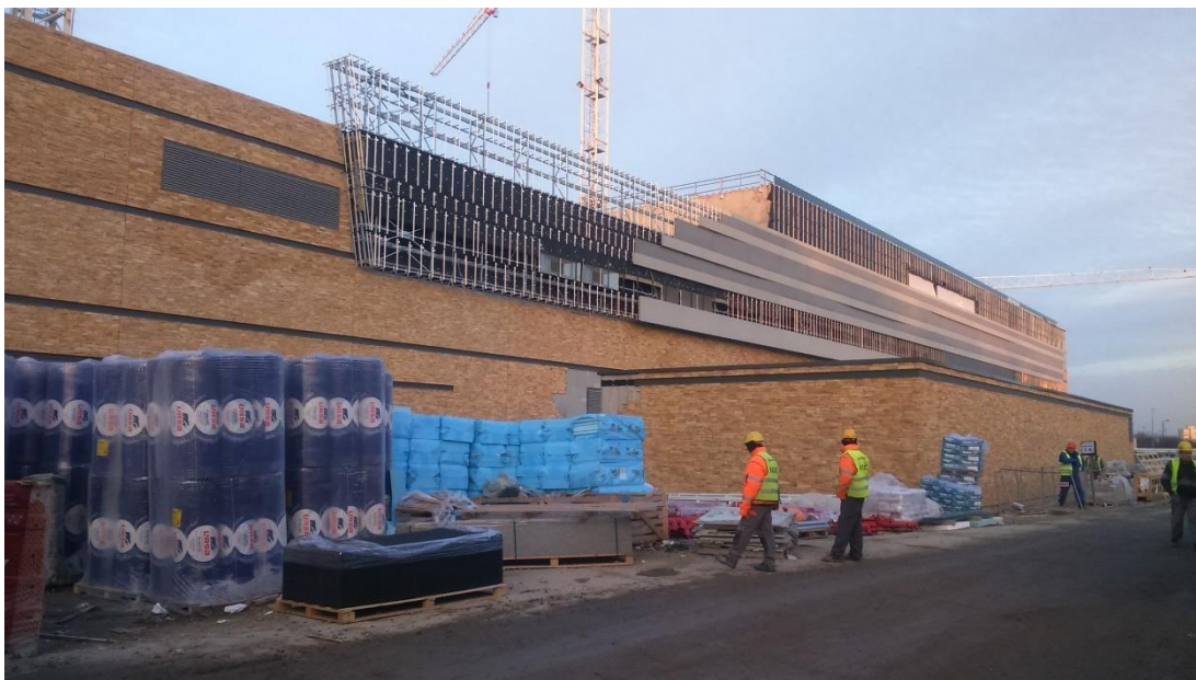
Foto 5.: Pohled na jižní fasádu obložení umělý kámen
