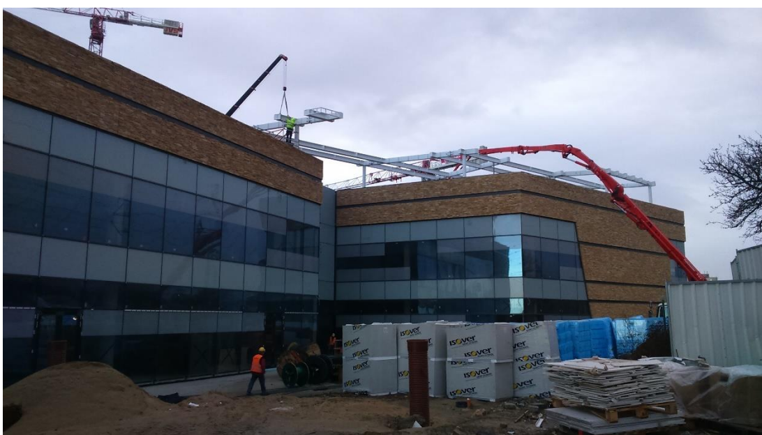
Foto 4.: Pohled na západní fasádu
