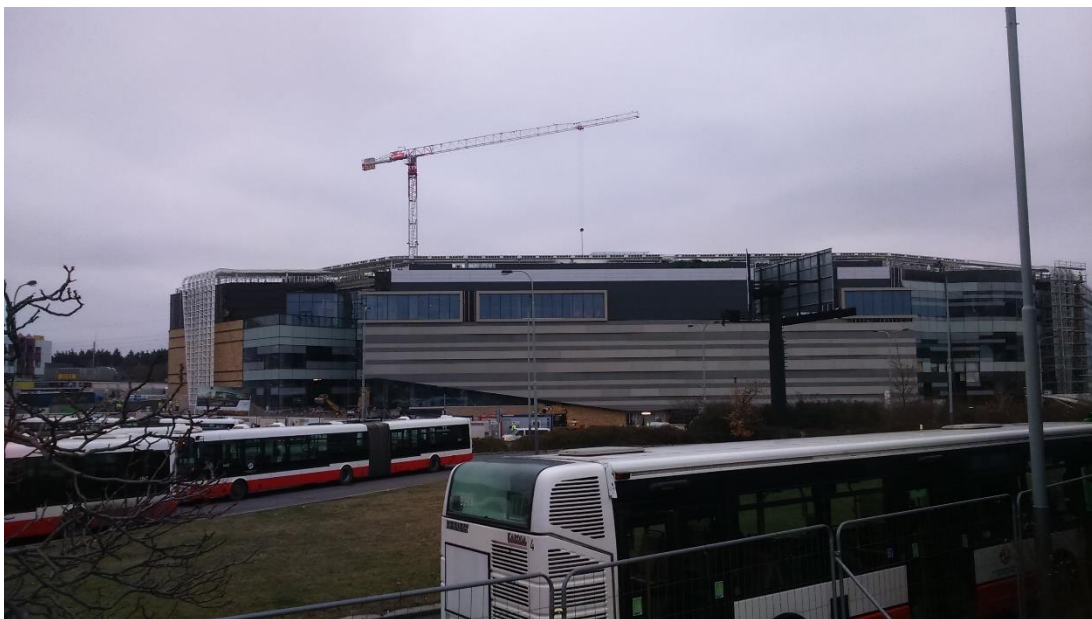
Foto 1.: Pohled na východní fasádu
