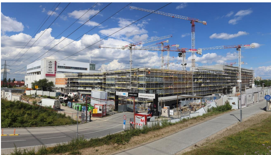
Foto 2.: Pohled na jižní a západní fasádu
