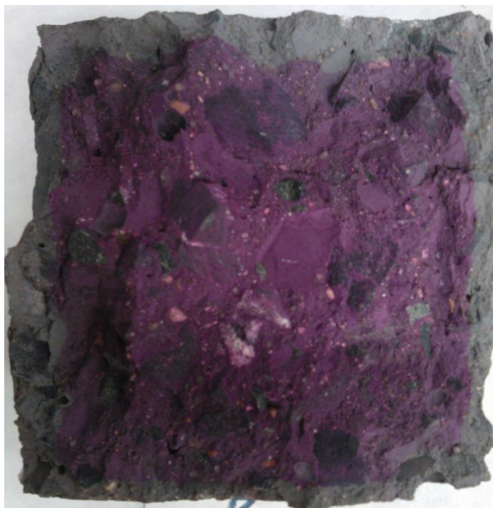
Obr. 4.1 – Rozdílná hloubka karbonatace u vzorku B-FPC 84 B
