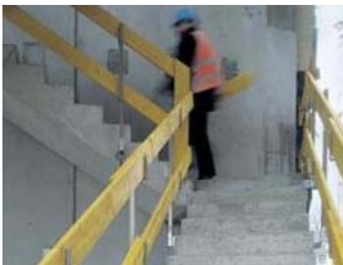
Obr. 24, Zábradlí proti pádu z výšky na schodišti, zdroj: scaservr.cz
