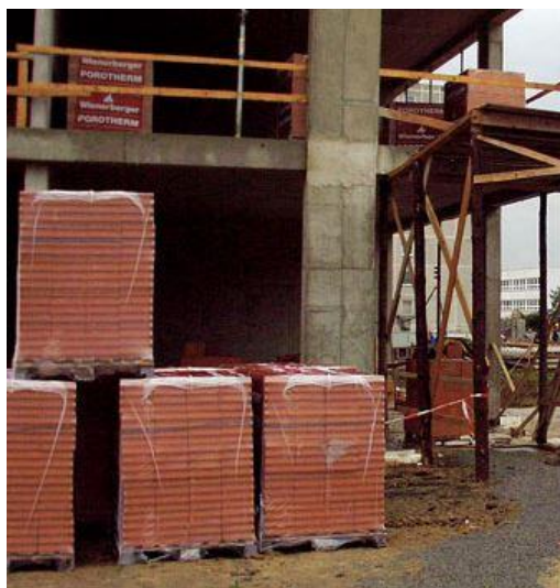
Obr. 29, Uskladnění cihelných bloků na staveništi, zdroj: asb-portal.cz
