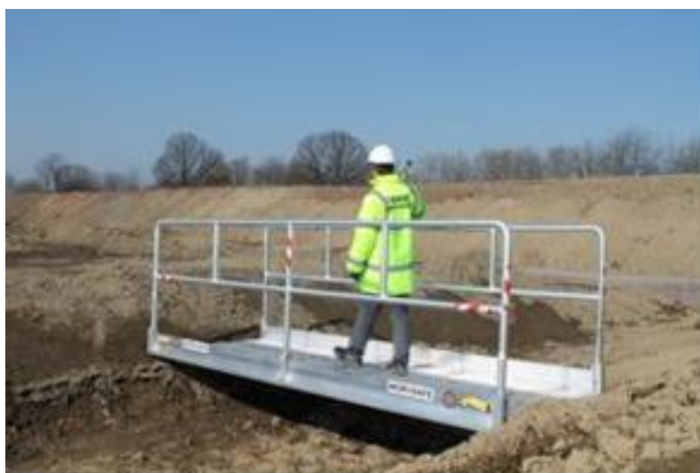
Obr. 15, Přechodová ocelová lávka, zdroj: scaserv.cz
