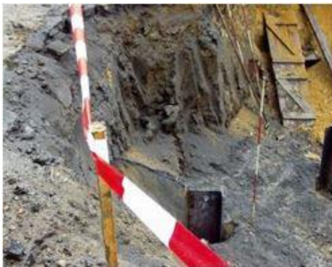
Obr. 13, Páska ohraničující výkop, zdroj: abs-portal.cz
