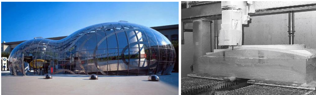
Obr. č. 10: BMW pavilon (vlevo), výroba forem fasádních panelů [24]
