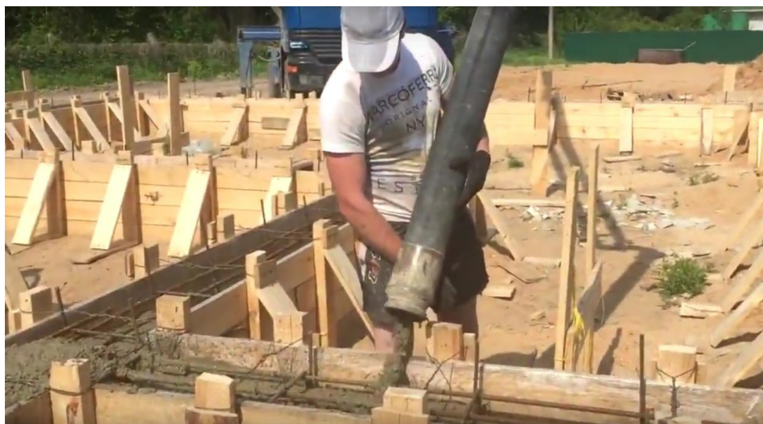
Obr. 10: Betonáž roštu
