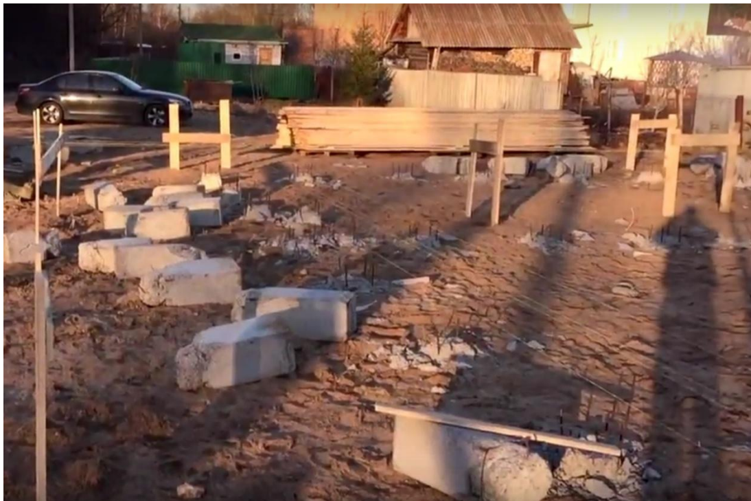
Obr. 7: Vytyčení pro železobetonový rošt
