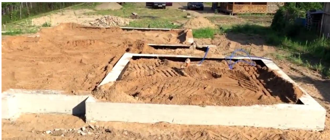
Obr. 11: Hotový železobetonový rošt
