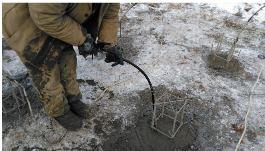
Obr. 20: Pumpování cementové směsi
