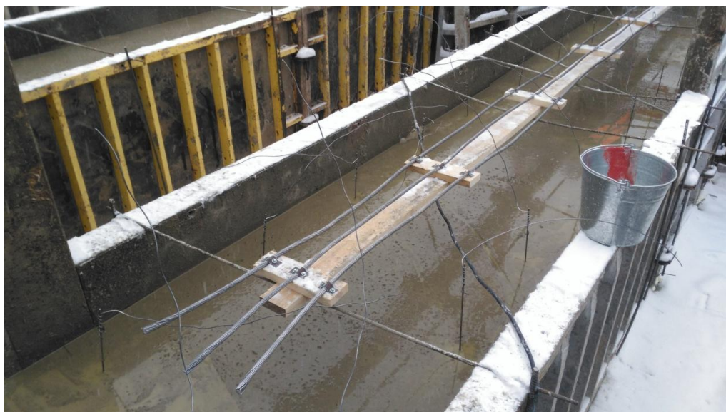
Obr. 28: Příprava k zahřívání betonu
