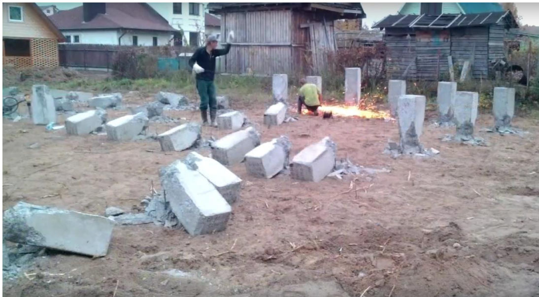
Obr. 5: Odřezávání prefabrikovaných pilot
