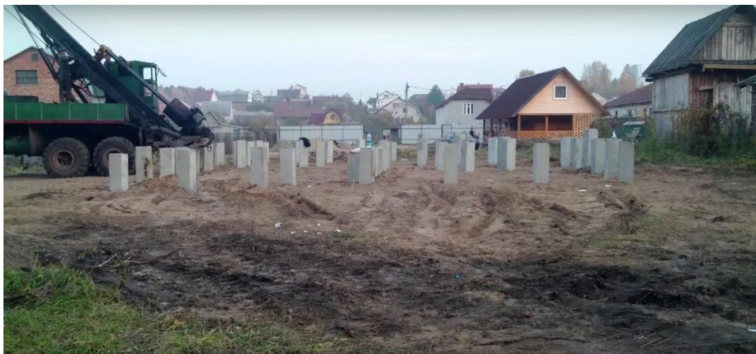
Obr. 4: Zarážené prefabrikované piloty
