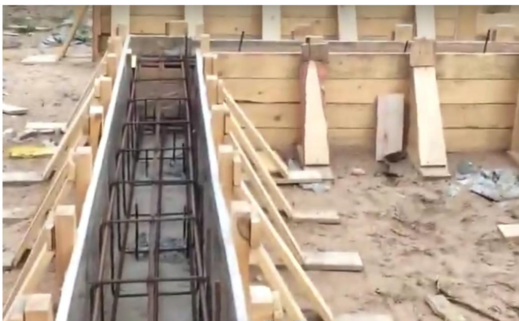
Obr. 9: Armování roštu
