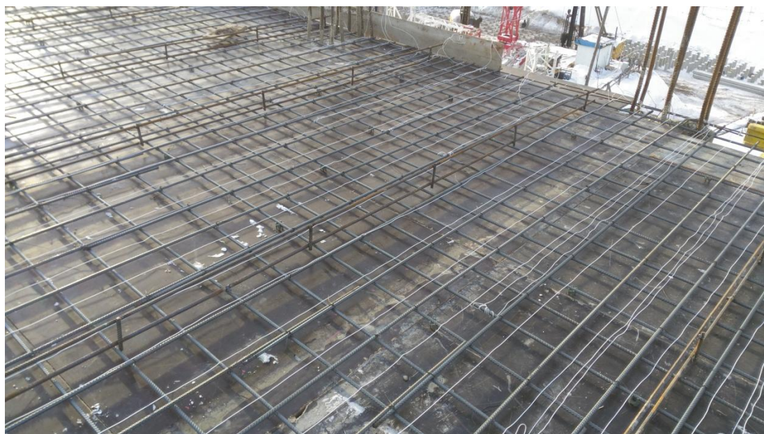
Obr. 34: Instalace topných vodičů
