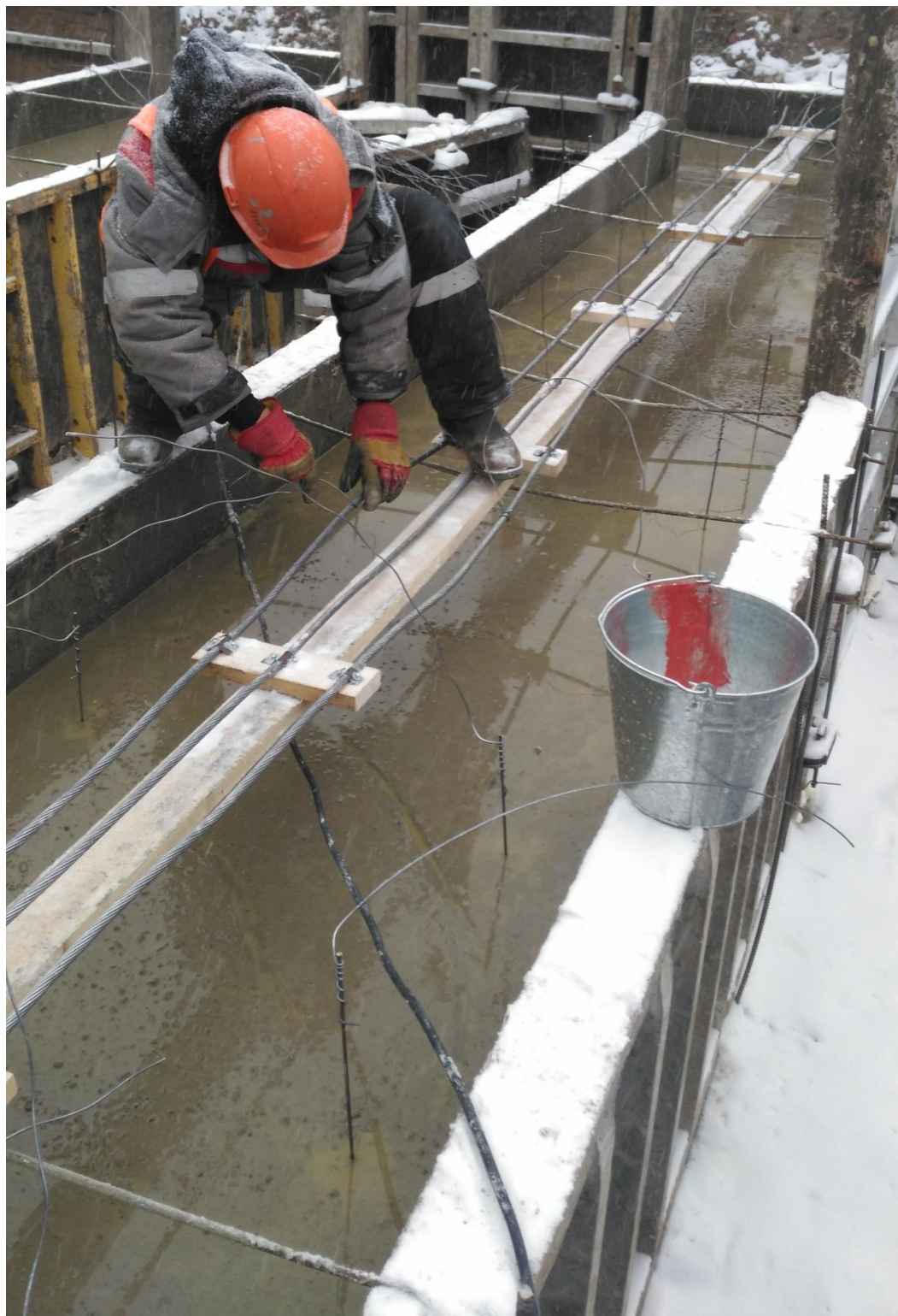
Obr. 36: Zapojení topných vodičů
