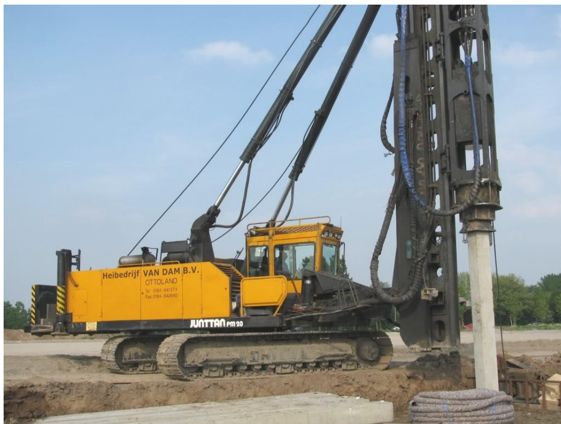
Obr. 2: Stroj na zarážení prefabrikovaných pilot
