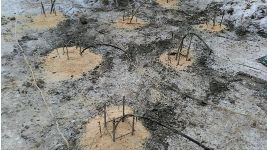
Obr. 22: Izolace pilot pomocí dřevěných pilin Zdroj: Vlastní tvorba autora
