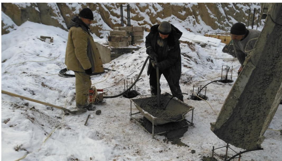
Obr. 18: Vibrování piloty
