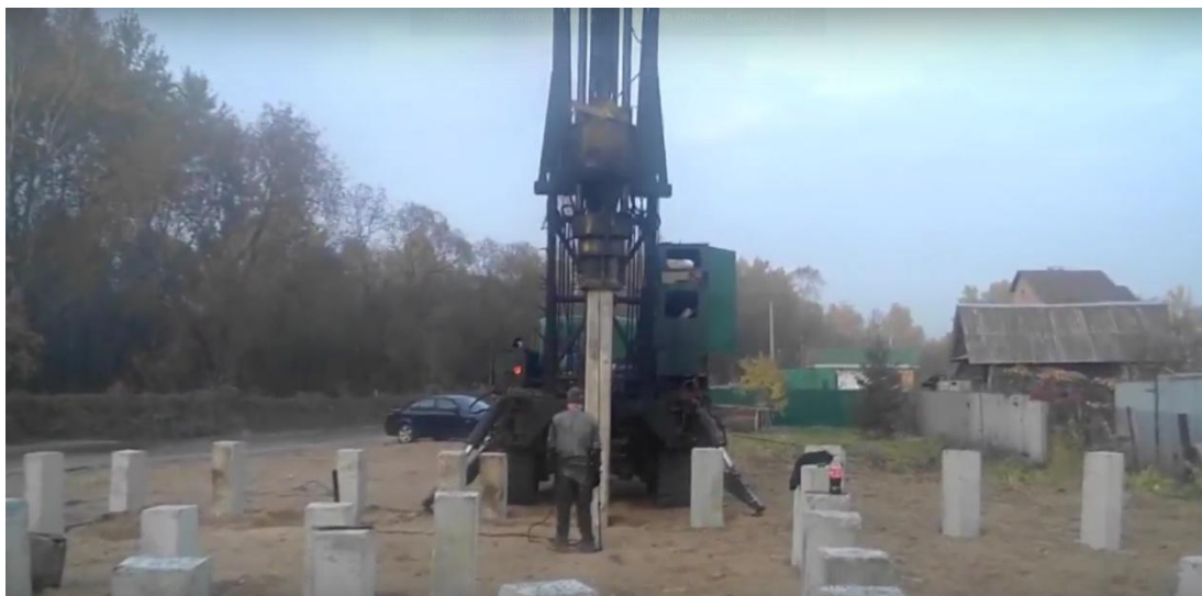
Obr. 3: Zarážení prefabrikovaných pilot
