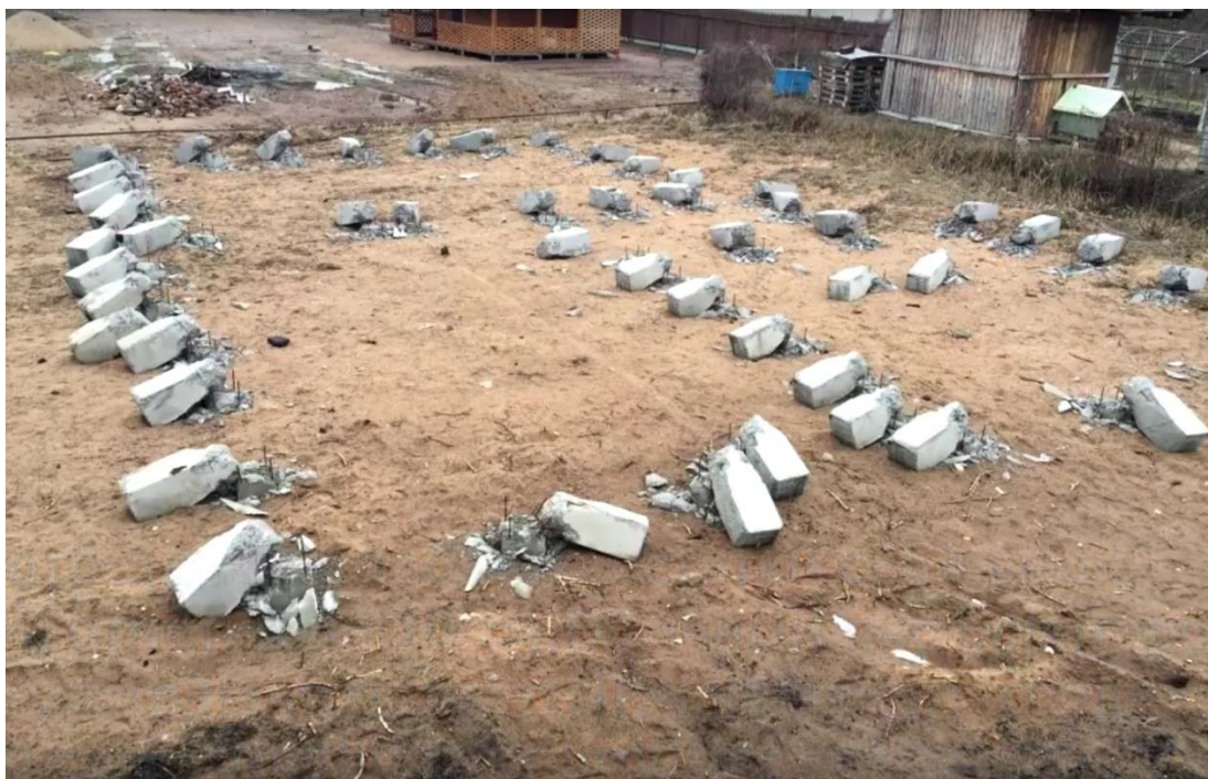
Obr. 6: Odřezané prefabrikované piloty
