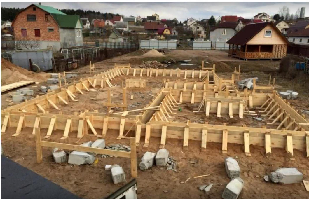
Obr. 8: Zhotovení dřevěného bednění
