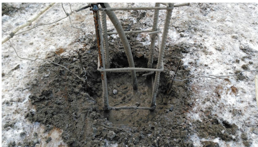
Obr. 21: Elektrický ohřev piloty
