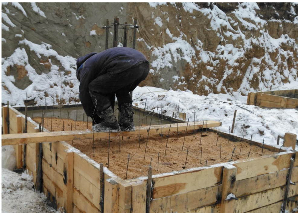
Obr. 24: Elektrický ohřev základové patky
