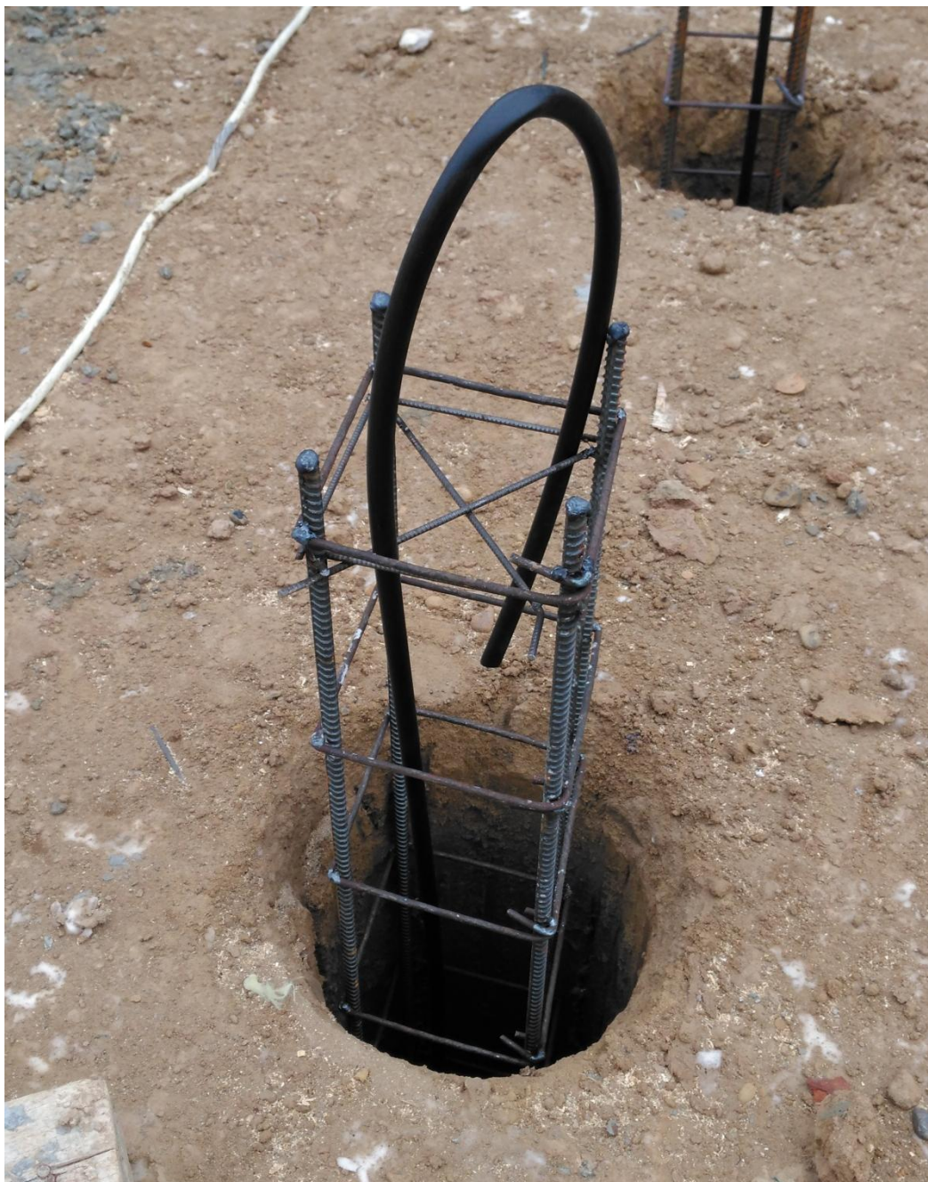
Obr. 15: Detail výztuže piloty
