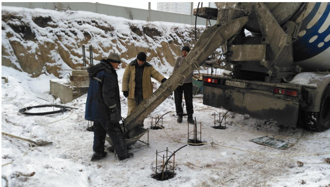
Obr. 17: Betonování piloty
