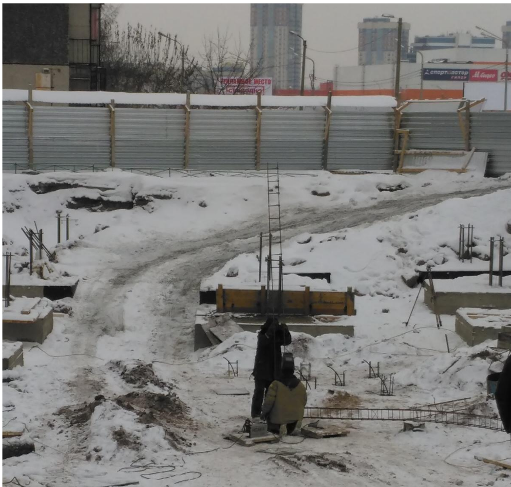
Obr. 16: Zasouvání armatury
