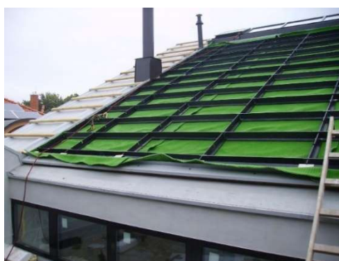
Obrázek 22 Rošt z recyklovaného polyethylenu (nosníky + prahy) [56]
