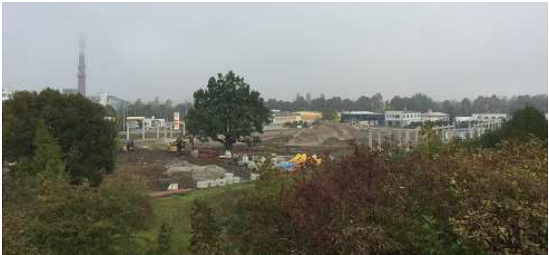
Obrázek 6: Výkopové práce; Zdroj: Vlastní zdroj
