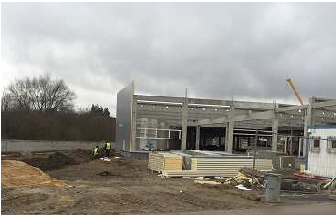
Obrázek 17: Montáž opláštění objektu; Zdroj: Vlastní zdroj
