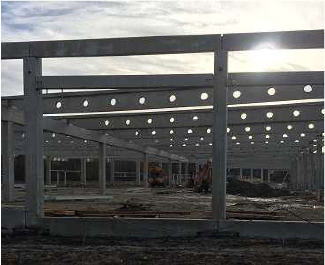
Obrázek 13: Železobetonová prefabrikovaná konstrukce; Zdroj: Vlastní zdroj
