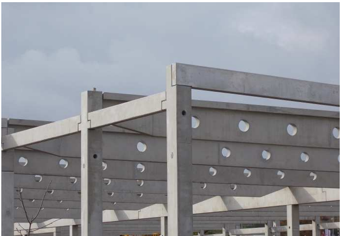
Obrázek 14: Železobetonová prefabrikovaná konstrukce - detail; Zdroj: Vlastní zdroj
