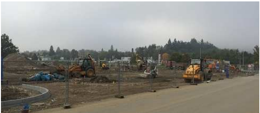
Obrázek 7: Úpravy terénu, montáž skeletu; Zdroj: Vlastní zdroj
