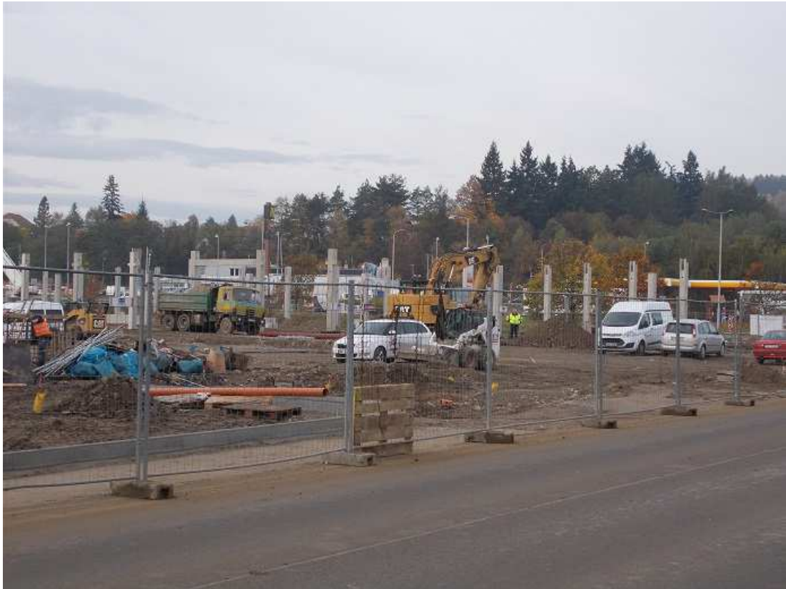
Obrázek 9: Montáž skeletu 2; Zdroj: Vlastní zdroj
