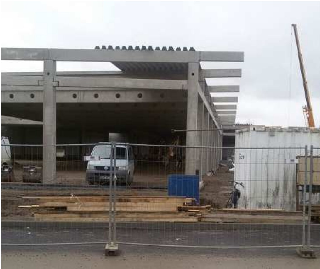
Obrázek 16: Montáž nosného trapézového plechu; Zdroj: Vlastní zdroj
