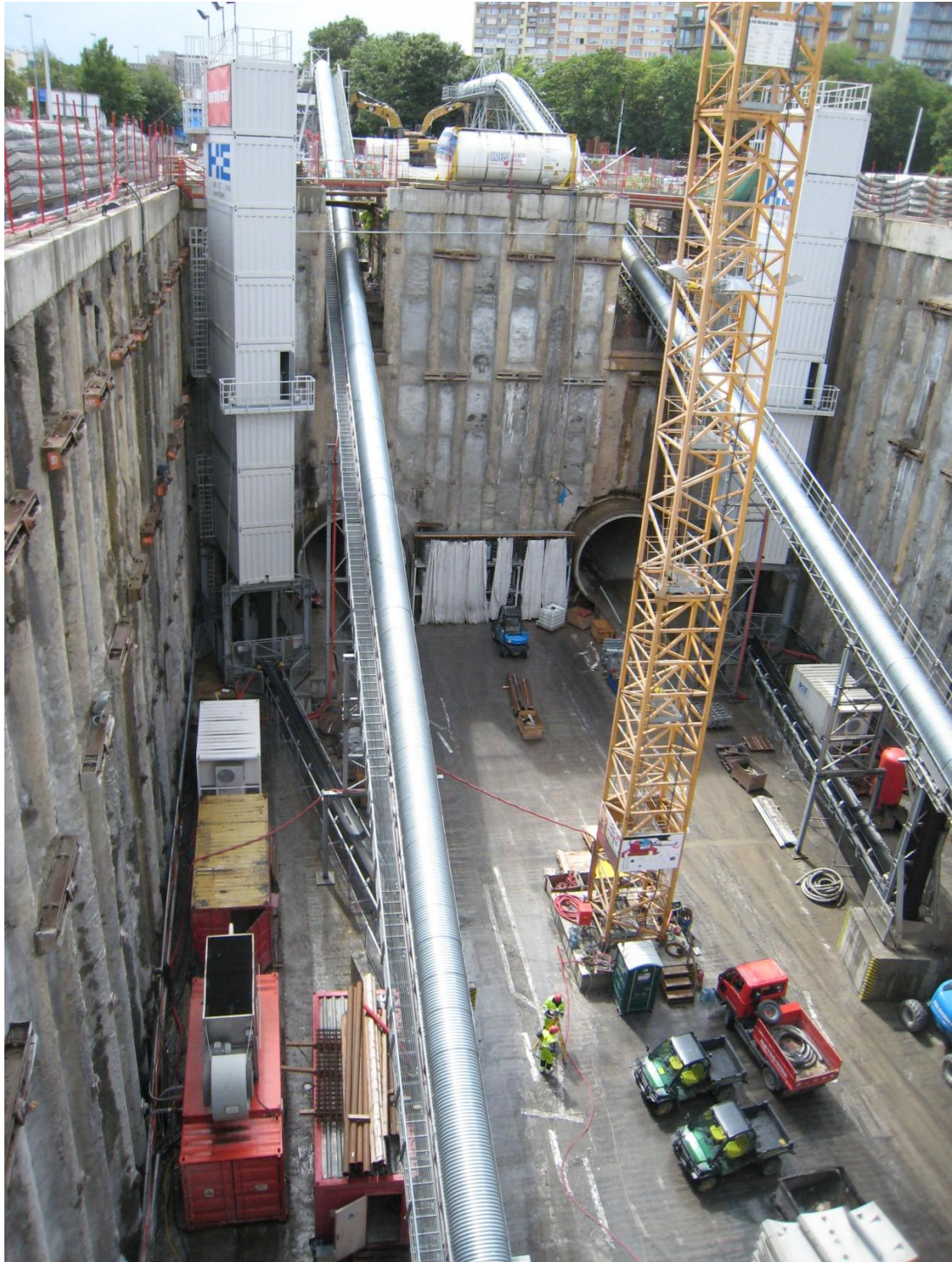
Obrázek 18: Pásový dopravník, napínací věže na reálné stavbě
