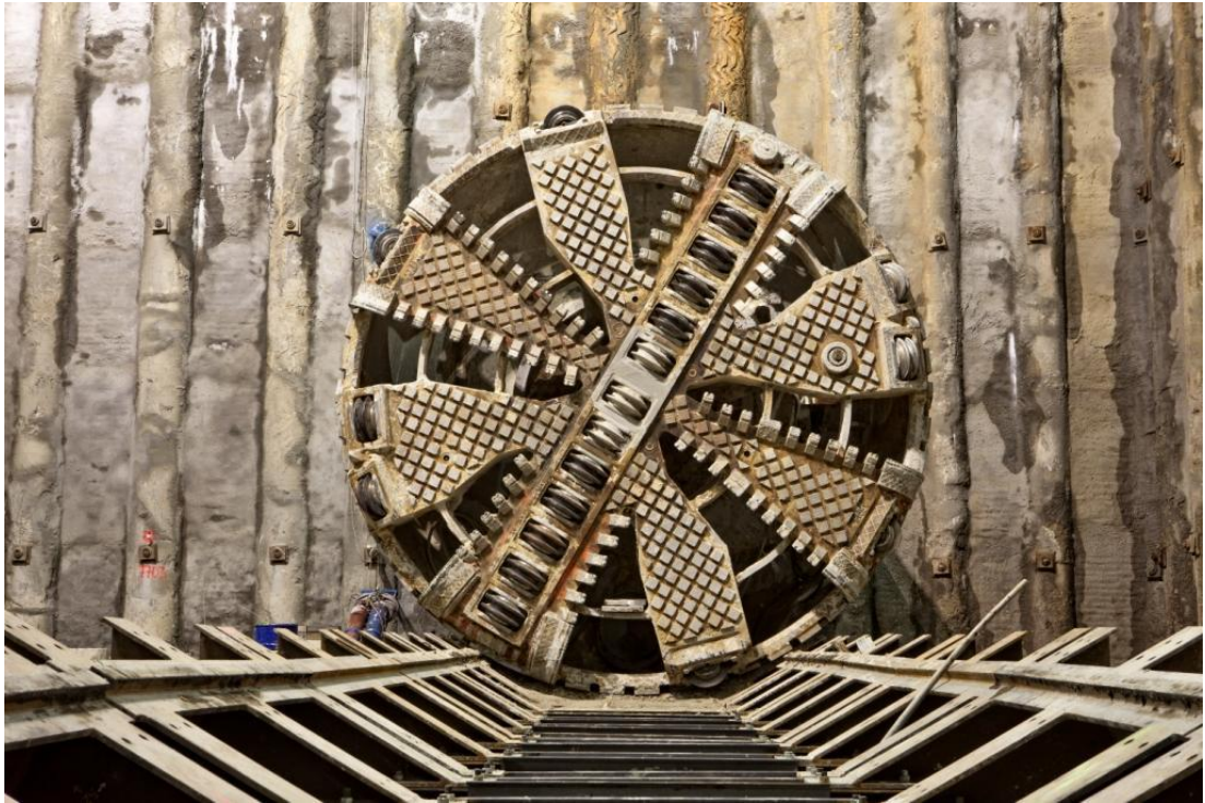
Obrázek 27: Vyjetí TBM z raženého tunelu na kolébku pro přeložení
