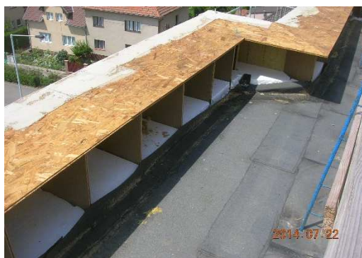
Obrázek 36 provedení okraje střechy bez vyvýšené atiky (zdroj: YIT Stavo, s.r.o.)
