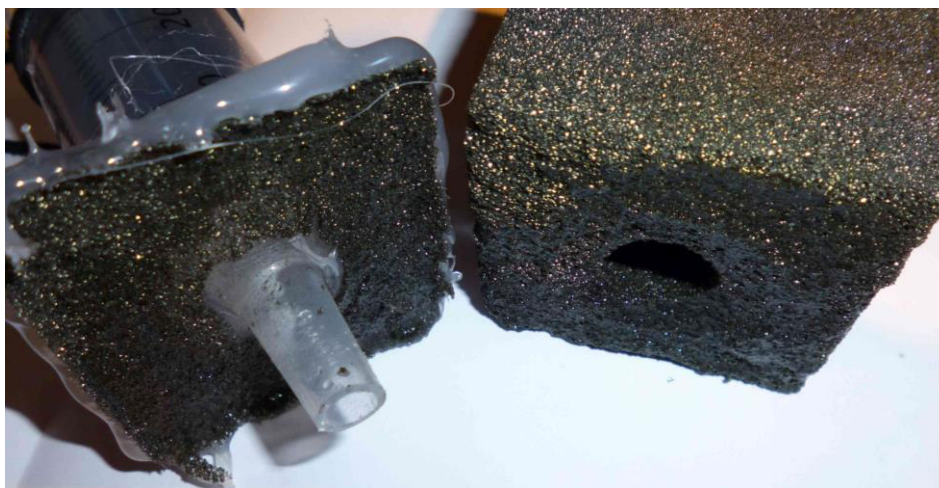
2.18 – Pohled na odtrženou vrstvu PS, do které pronikala voda.
