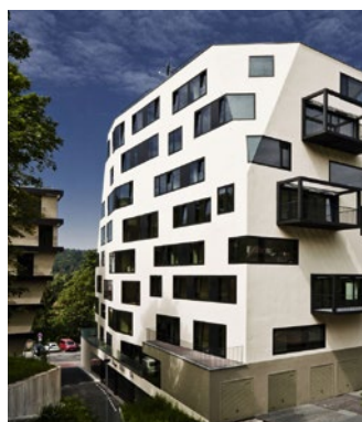
Triplex – bytový dům, Karlovy Vary
