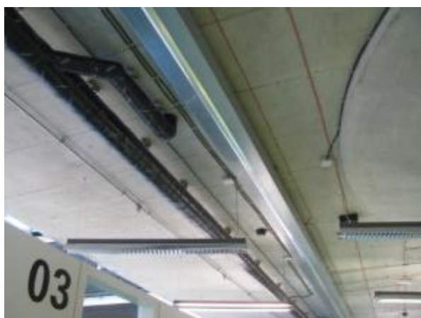
Obr. 11 - detail přiznaného rozvodu instalací
