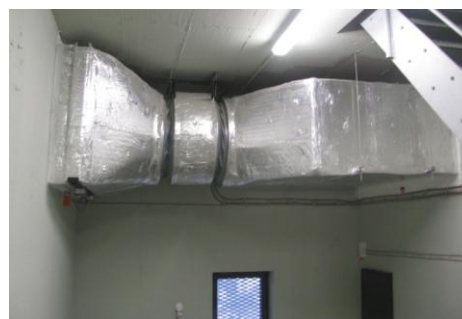
Obr. 15 - detail prostupu vzt potrubí
