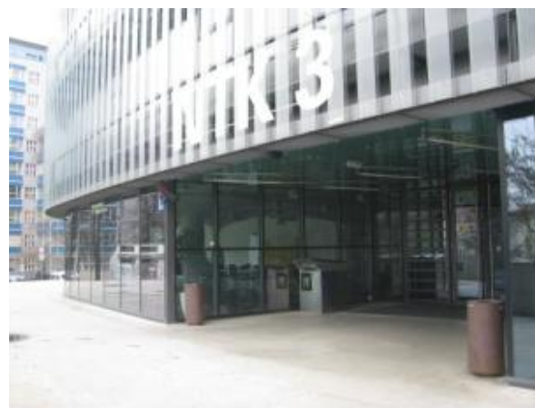
Obr. 12 - pohled na fasádu a okenní prvky budovy
