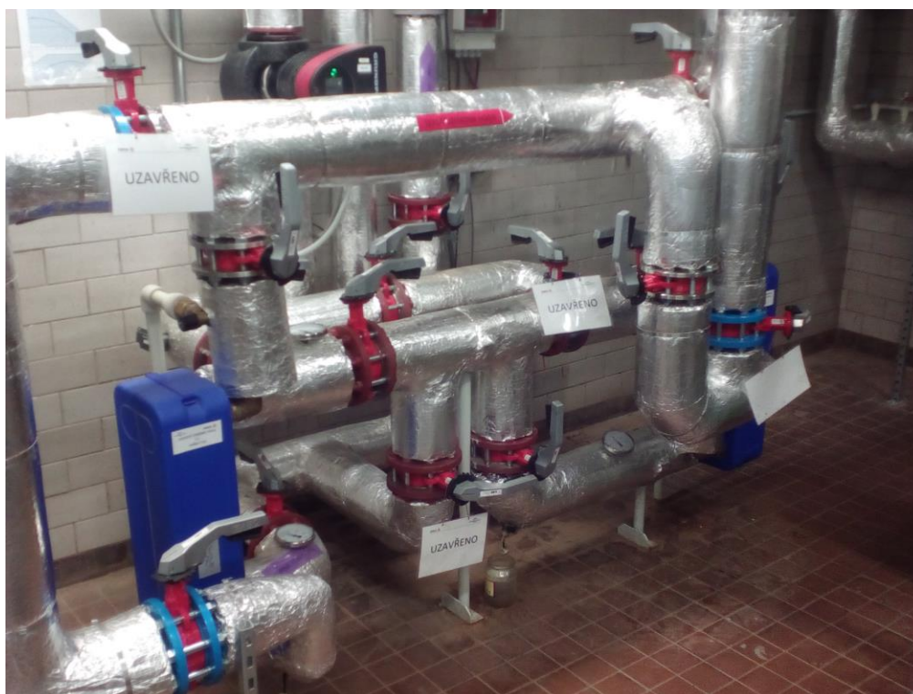
Obrázek 3-11 - Zapojení deskových výměníků
