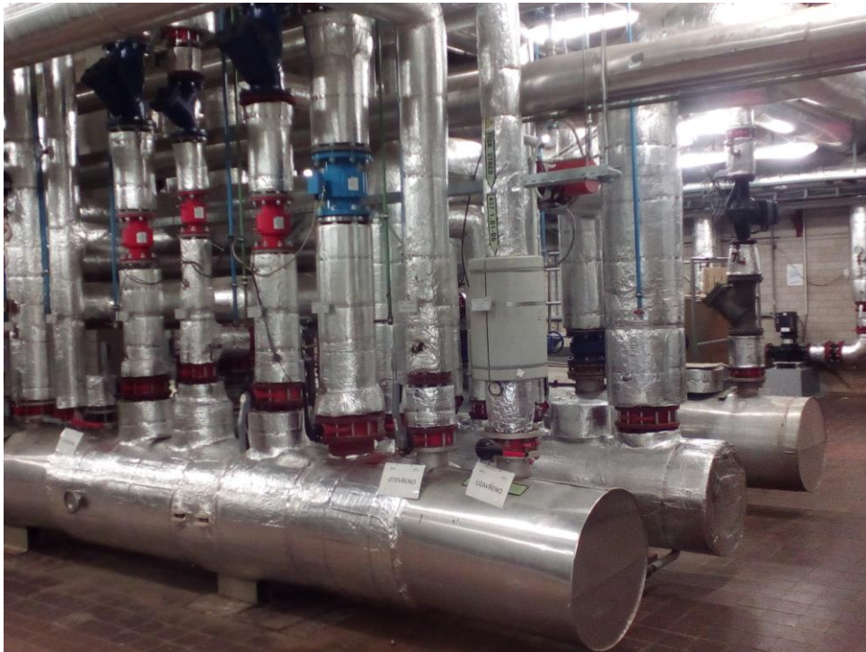
Obrázek 3-13 - Sběrače a Rozdělovač
