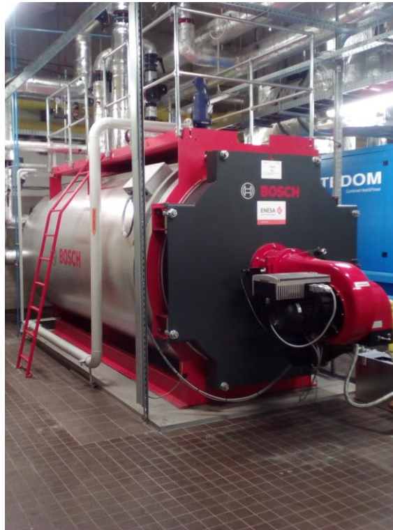
Obrázek 3-5 - Kotel Bosch K3
