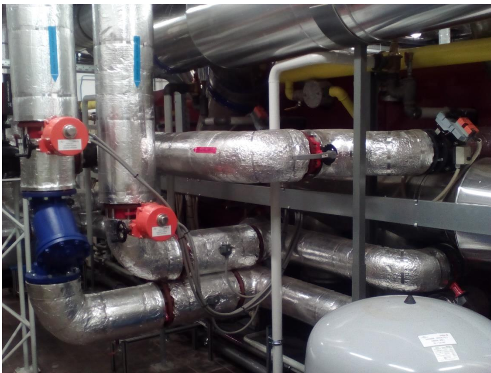
Obrázek 3-2 - Napojení dvojkotle Hoval
