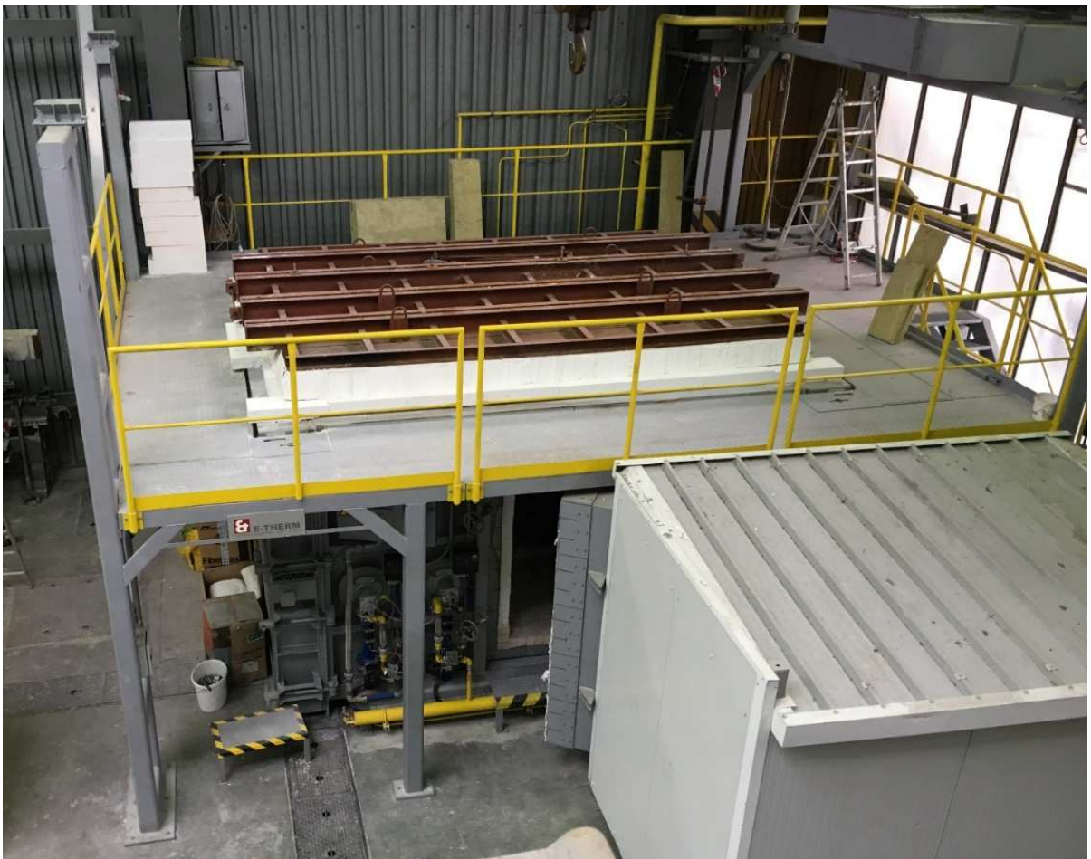
Obr. 8 Vodorovná požární pec ve zkušebně PAVUS a.s. ve Veselí nad Lužnicí.
