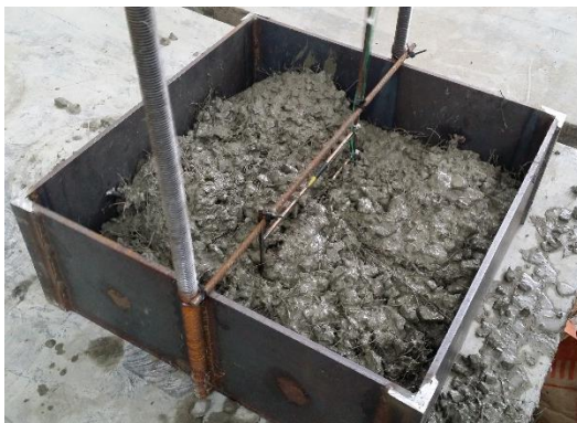
Obrázek 43. Vybetonování forem (Vlastní 2016)
