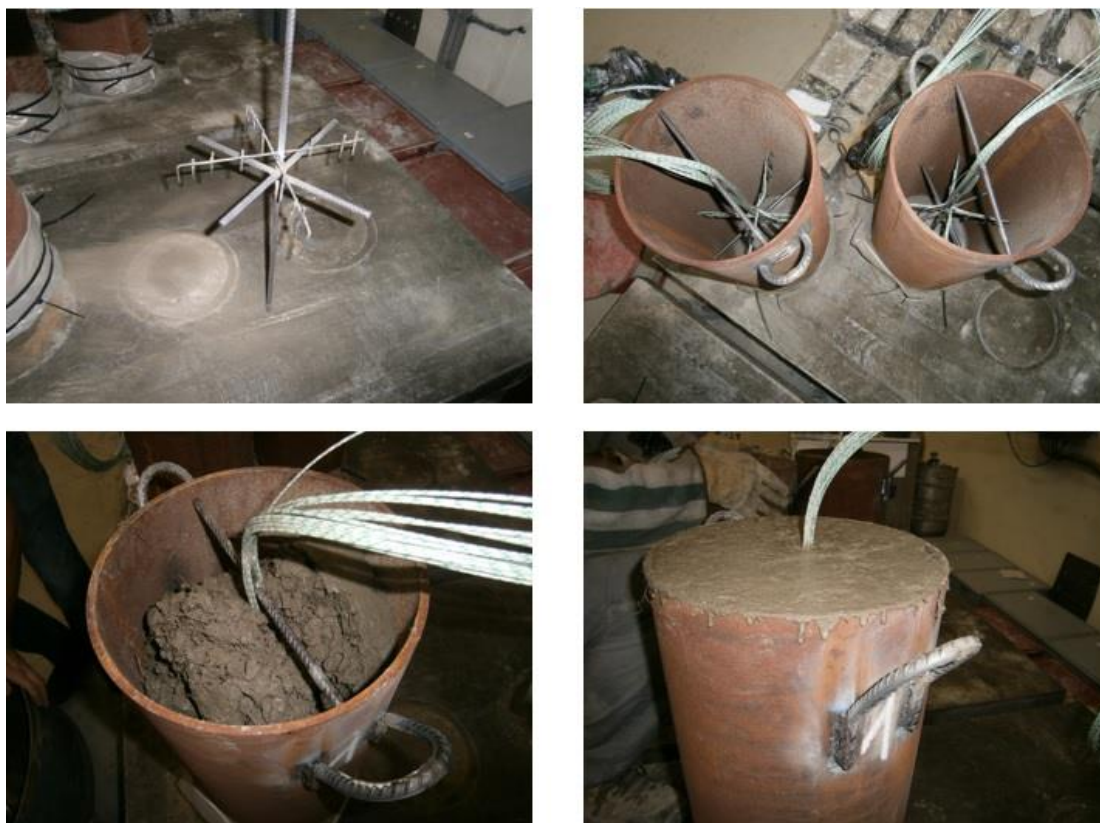
Obrázek 45. Průběh výroby a betonáže ocelobetonového sloupu (Štefan, 2016)
