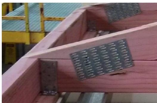
Obrázek 48 - Upevnění vazníku do horního rámu konstrukce (23)
