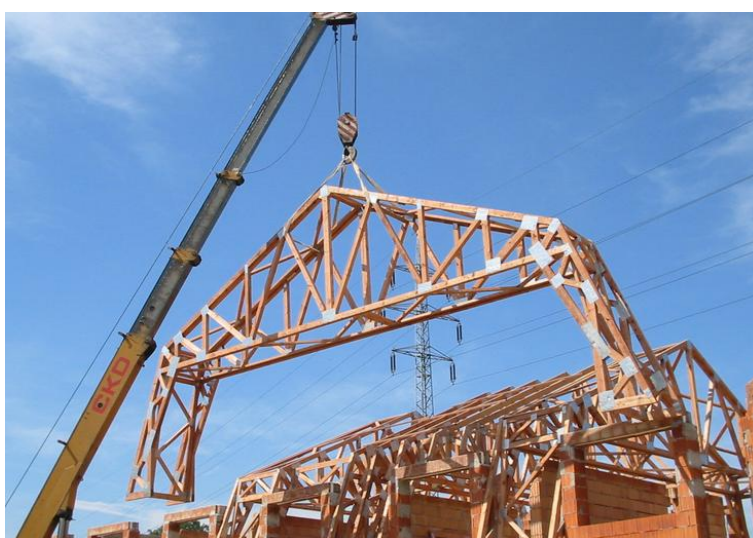
Obrázek 6 - Prefabrikovaná konstrukce s ocelovými styčnickovými deskami firmy Mitek Industries ( http://www.mitek.cz/ )
