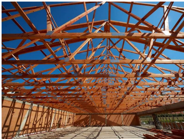
Obrázek 7 - Velkorozponový příhradový vazník společnosti Mitek Industries ( http://www.mitek.cz/ )
