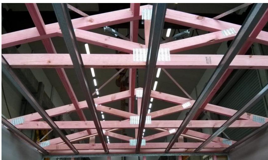
Obrázek 49 - Fotografie zobrazující příhradové vazníky a umístění stropních ocelových lišt (23)
