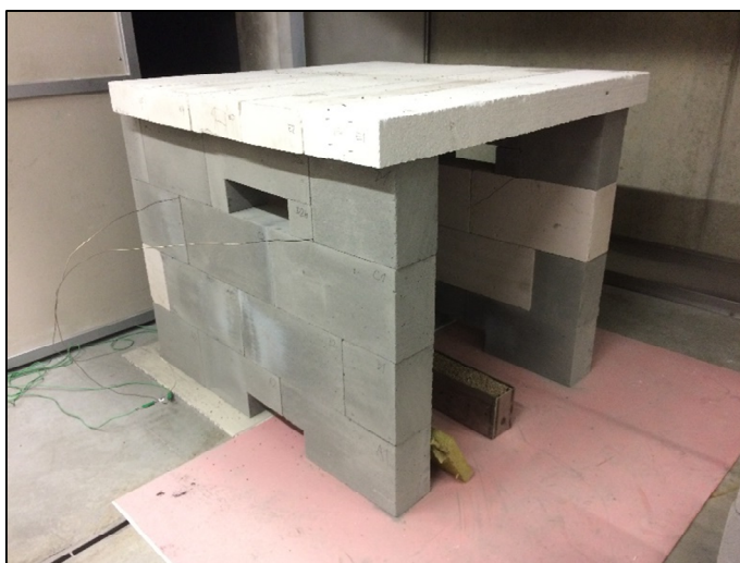
Výstavba zkušební pece
