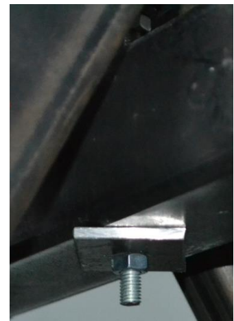
Obrázek 58: Detail uchycení závitové tyče závěsu k pomocnému ocelovému rámu
