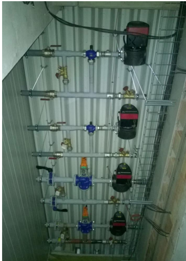
Obrázek 37: Ukázka zavěšení čerpadel o váze 100 kg
