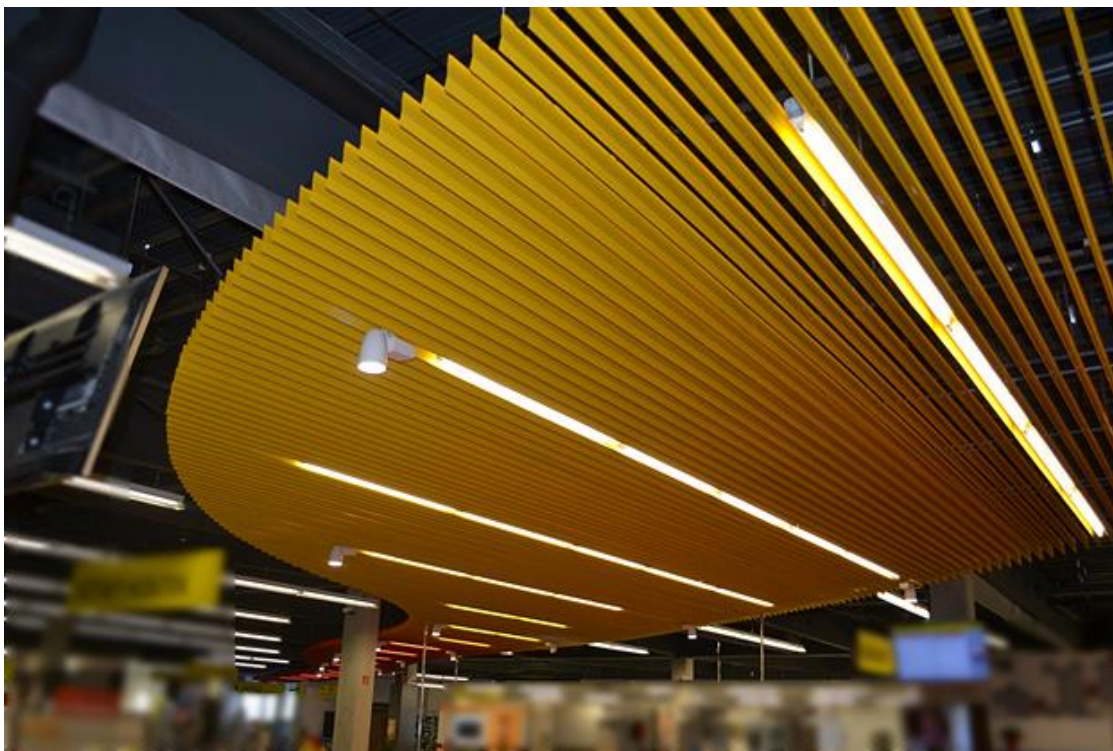
Obrázek 35: Zavěšení podhledové konstrukce
