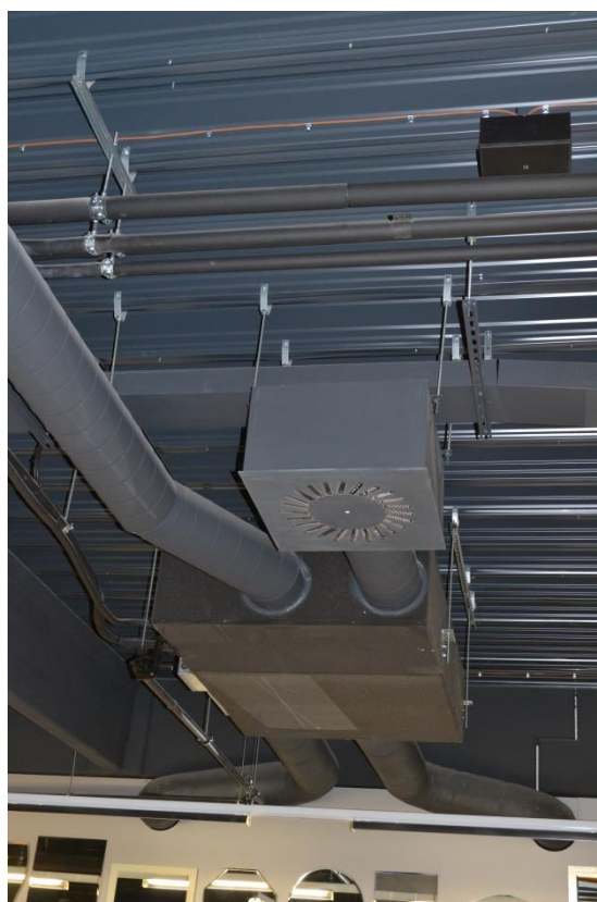
Obrázek 36: Detail zavěšení podhledové konstrukce a ukázka zavěšení VZT jednotky
