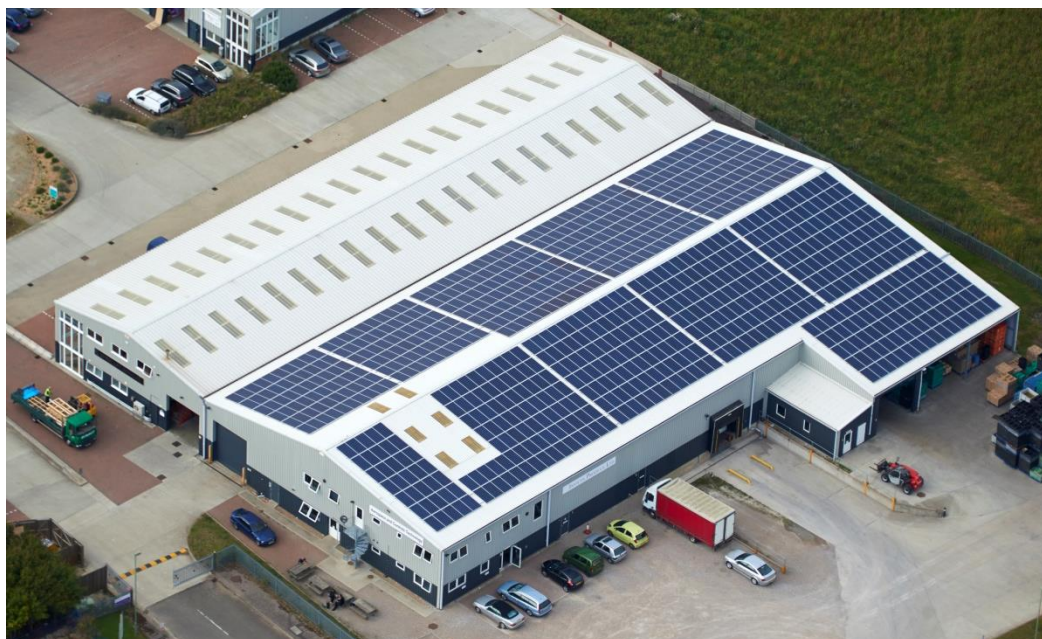
Obrázek 32: Ukázka instalace solárních panelů na halový objekt [5]
