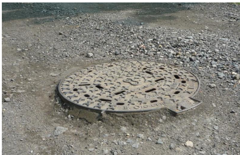
Obrázek 28: Poklop s vymletou spodní stranou
