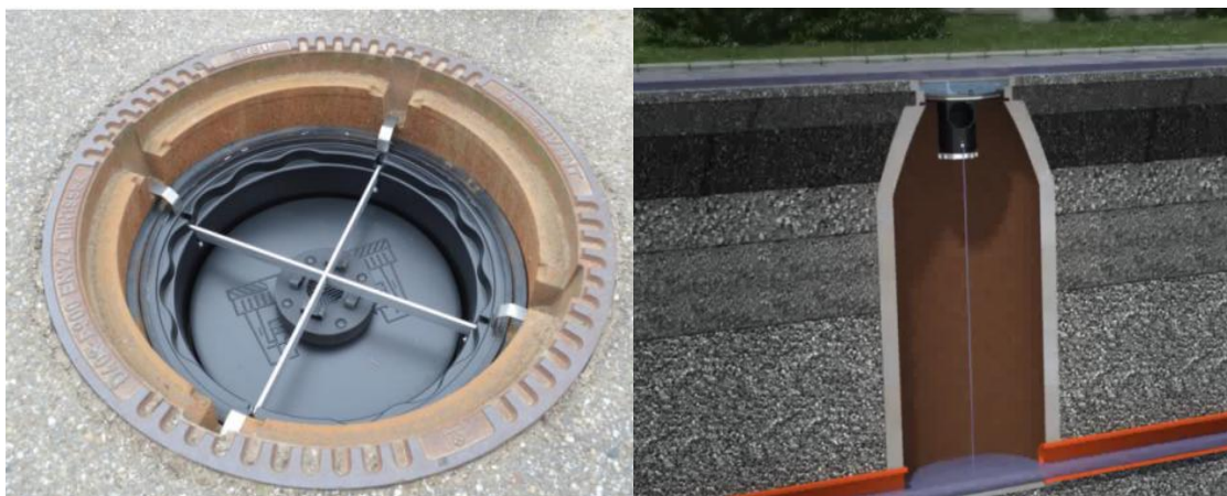
Obrázek 13: Ukázka dvou typů vložek do šachet, jejich umístění a funkčnost [59] [60]
