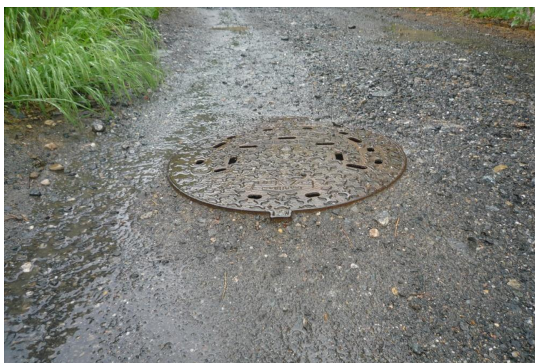
Obrázek 29: Vhodnější orientace pantů poklopu ze svahu
