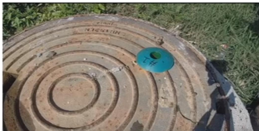
Obrázek 11: Ukázka umístění hříbu v poklopu [28]
