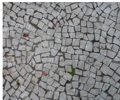
Nepravidelná dlažba ze štípaných žulových kostek.
